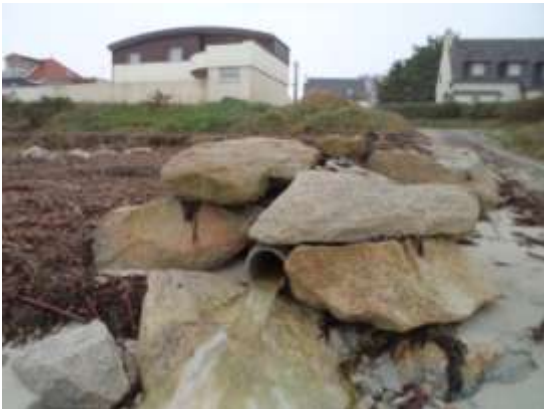
Photo 3 : Photo de l'exutoire de Kerurus – Côté terre
