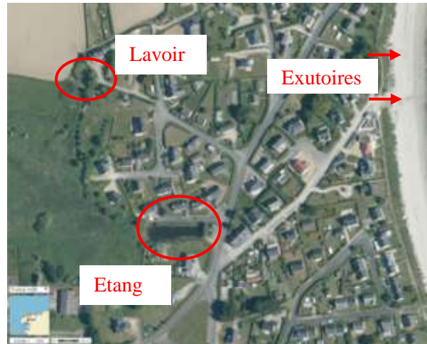
Photo 5 : Photo aérienne de l'exutoire
