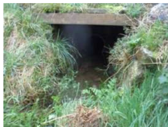
Photo 2 : Exutoire de Mez ar Pont
