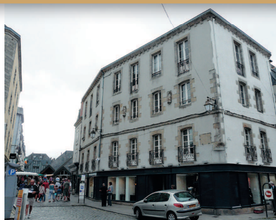
▲ L'immeuble le plus au sud, au 1 place Terre-au-Duc.
