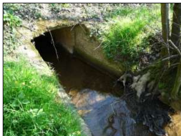
Vue aval de l'ouvrage hydraulique n°5
