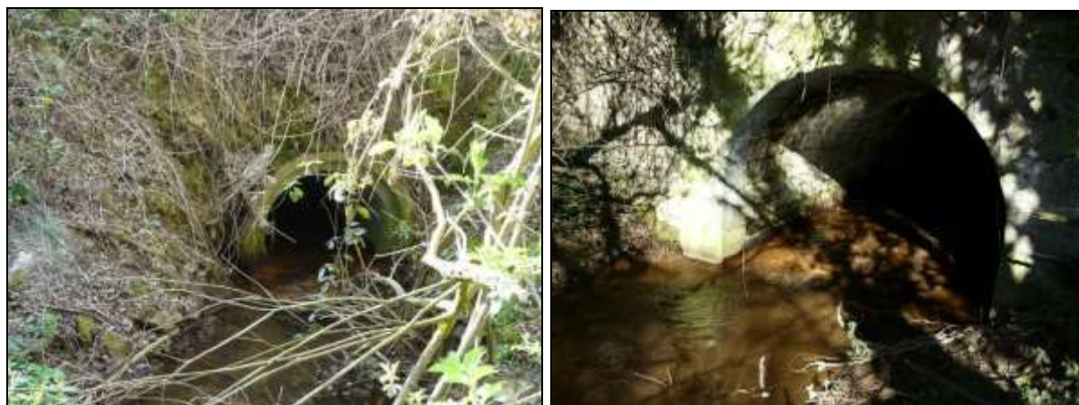
Vues amont et aval de l'ouvrage hydraulique n°6
