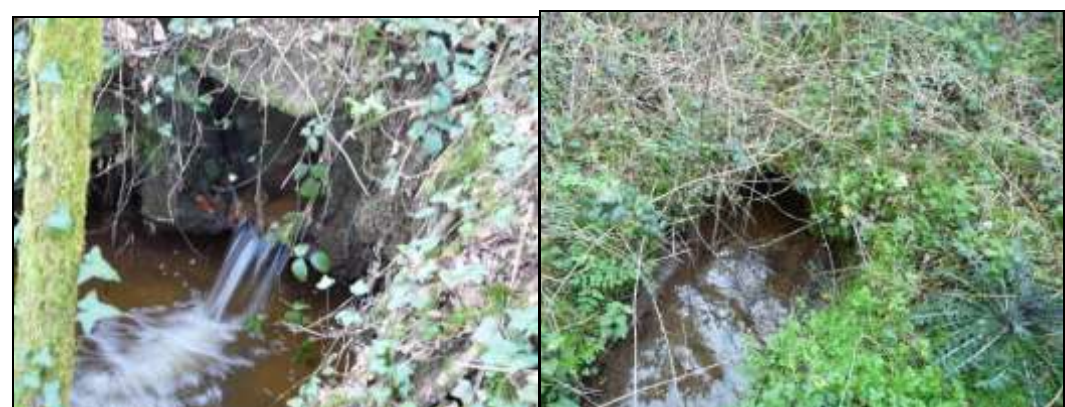
Figure 4 : Vues aval de l’OH n°7 et de la buse située directement à l’amont
