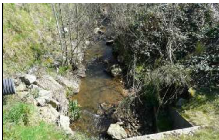
Figure 2 : Vue du ruisseau de Plémet entre l'OH-Pb et l'OH-Pa
