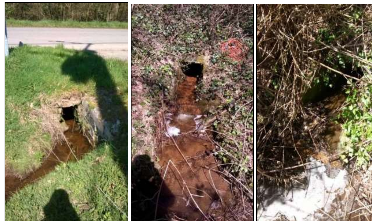
Vues des ouvrages hydrauliques OH-2d (à gauche), OH-2 (au milieu) et OH-1 (à droite)
