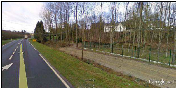
Photo 1 : route en déblai
