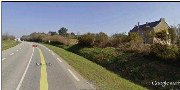
Photo 1 : route en déblai
