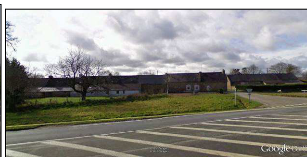
Photo 2 : habitations RDC et R+1
