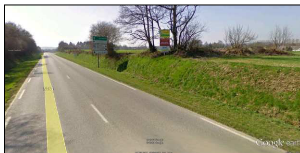
Photo 3 : route en déblai
