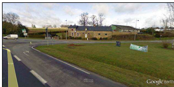
Photo 2 : habitations R+1 et hangar
