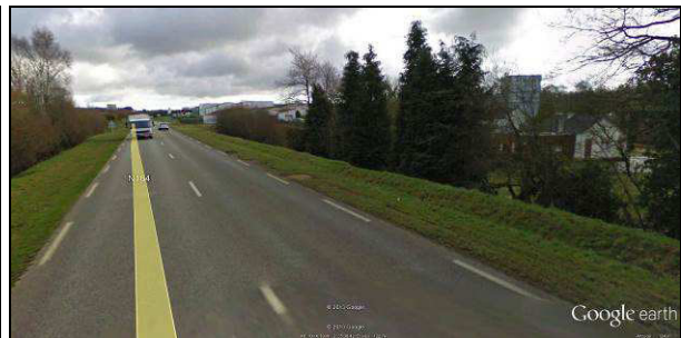
Photo 2 : route en remblai
