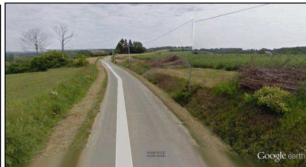
Photo 2 : talus le long de la route
