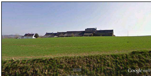
Photo 1 : habitations Rdc et R+2
