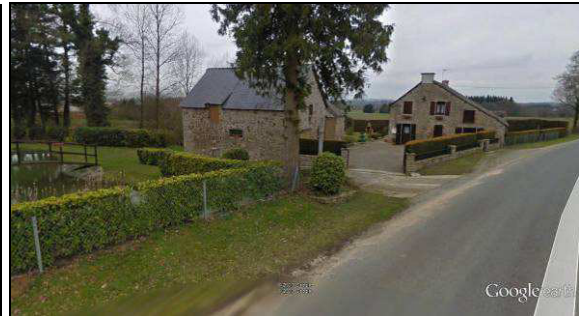
Photo 10 : habitations R+1 et hangar
