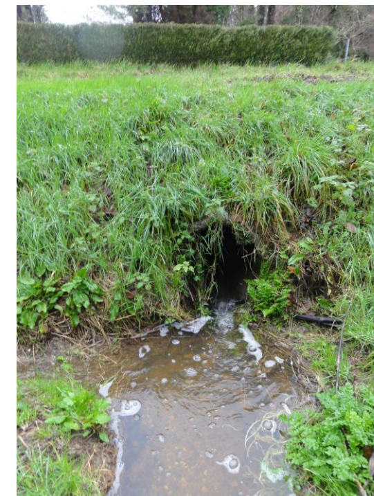
Photographie 10: Côté aval de l'ouvrage situé sous la RN 164
