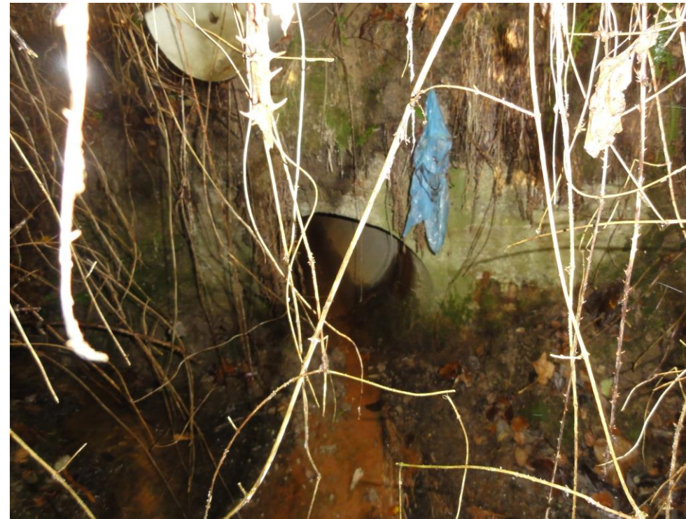
Photographie 6: Côté aval de l'ouvrage situé sous la RN 164
