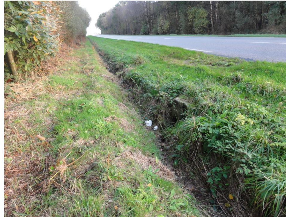
Photographie 1 : Côté amont de l'ouvrage situé sous la RN 164
