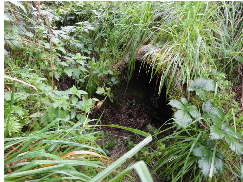
Photographie 5: Côté amont de l'ouvrage situé sous la RN 164
