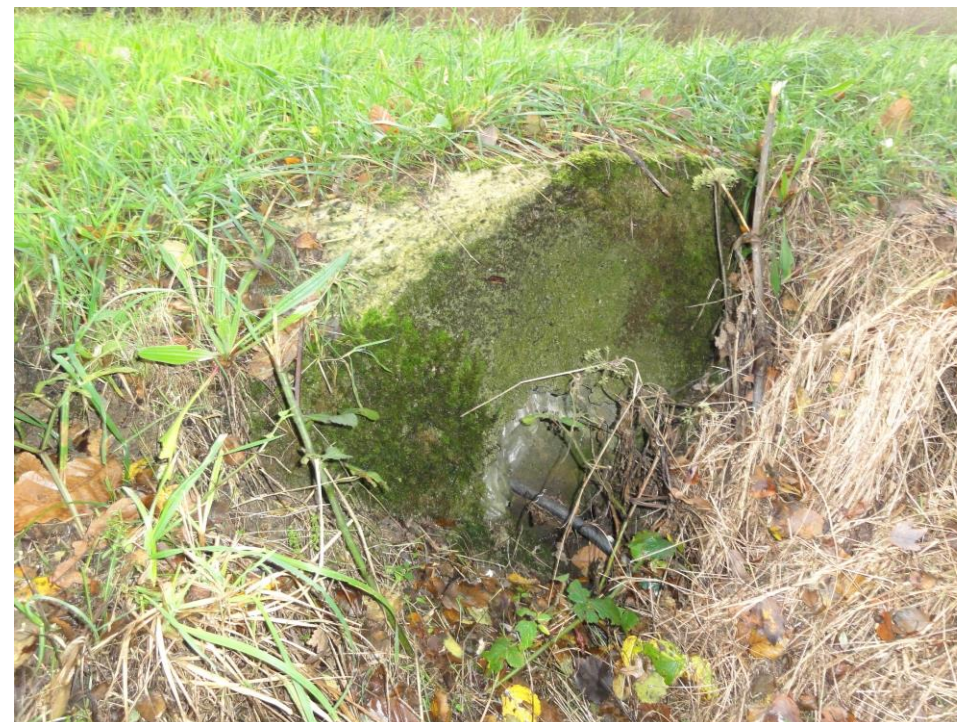
Photographie 2: Côté aval de l'ouvrage situé sous la RN 164
