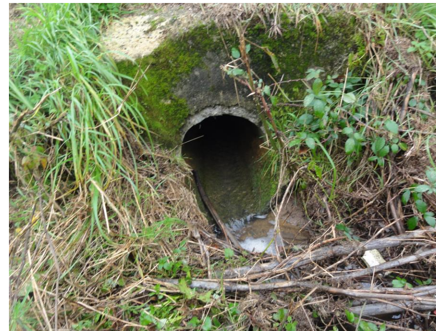
Photographie 4: Côté aval de l'ouvrage situé sous la RN 164
