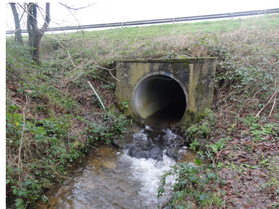
Photographie 8: Côté aval de l'ouvrage situé sous la RN 164
