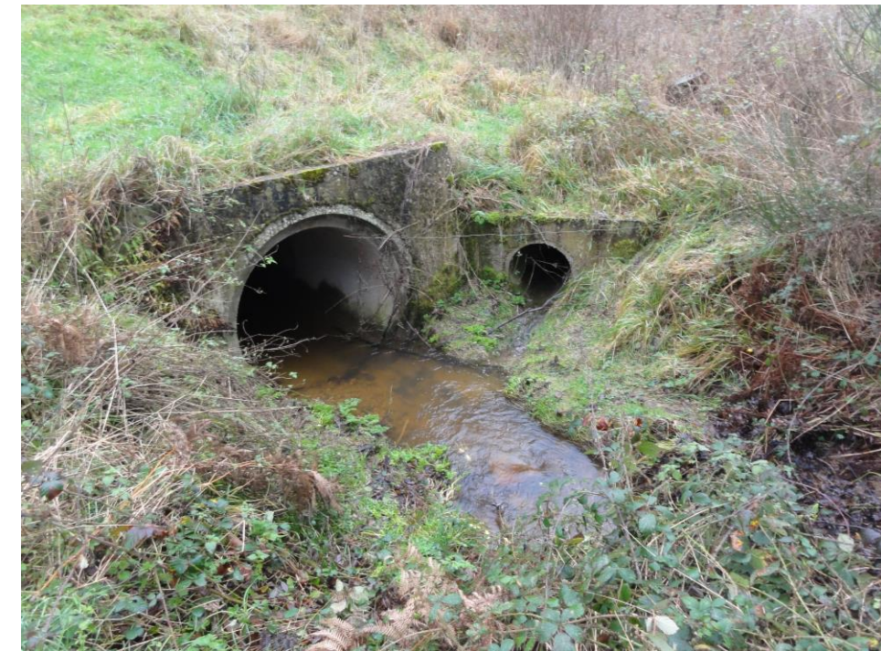
Photographie 7 : Côté amont de l'ouvrage situé sous la RN 164
