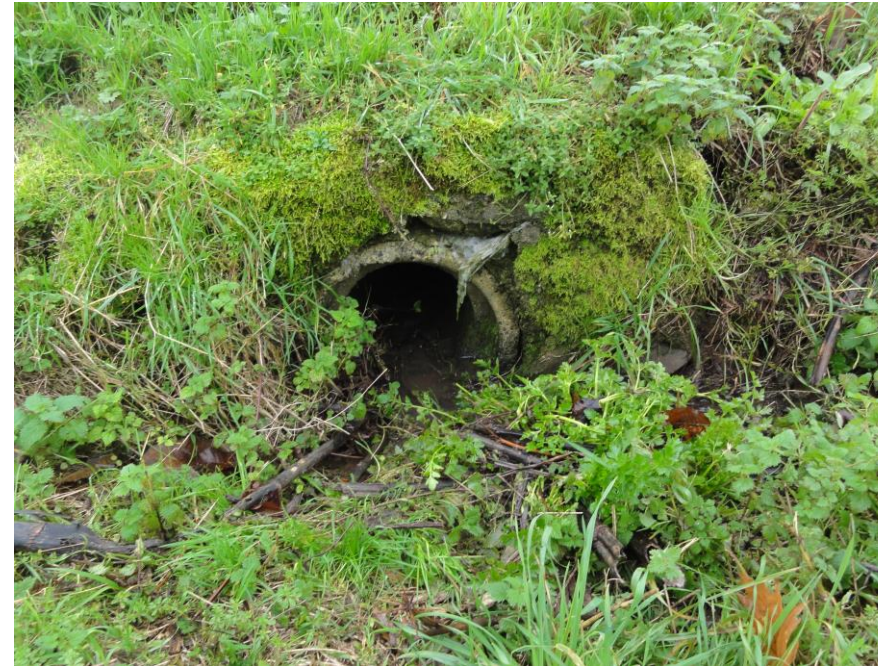
Photographie 3: Côté amont de l'ouvrage situé sous la RN 164
