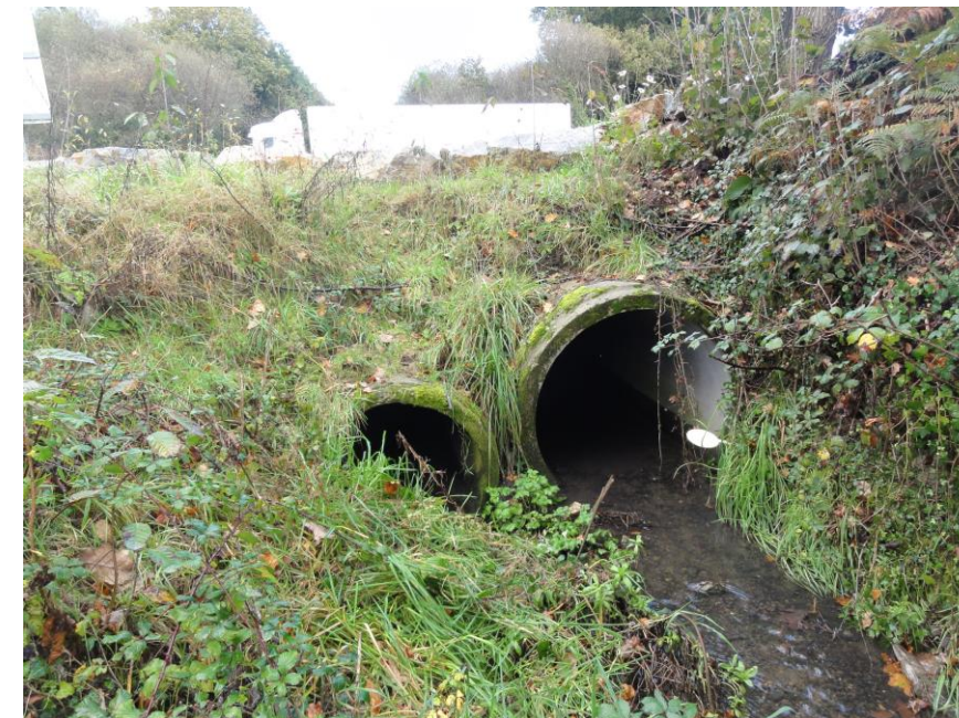
Photographie 14: Côté aval de l'ouvrage situé sous la RN 164
