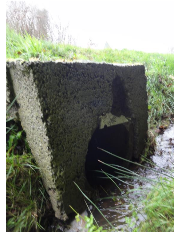
Photographie 9 : Côté amont de l'ouvrage situé sous la RN 164
