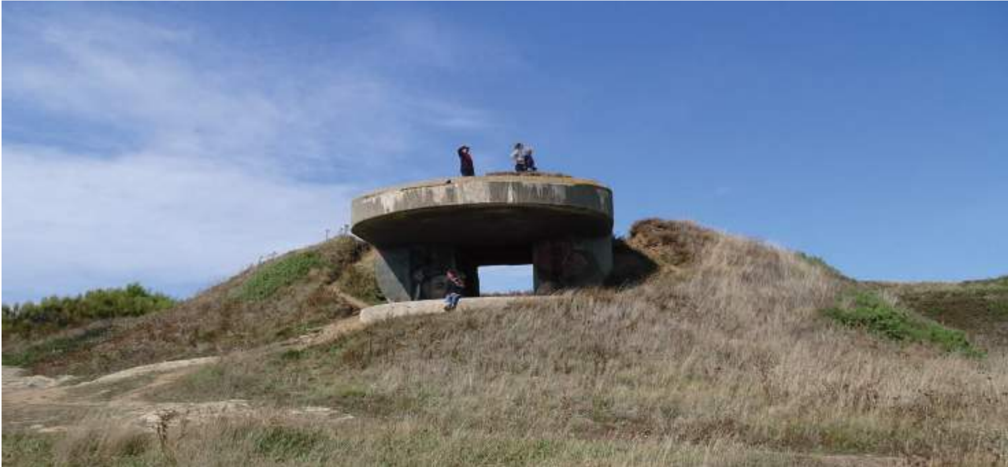
Le bunker « porte-à-faux » contribue beaucoup au caractère pittoresque du paysage, par sa forme singulière qui l'apparente à une «fabrique», et par son rôle de belvédère.
