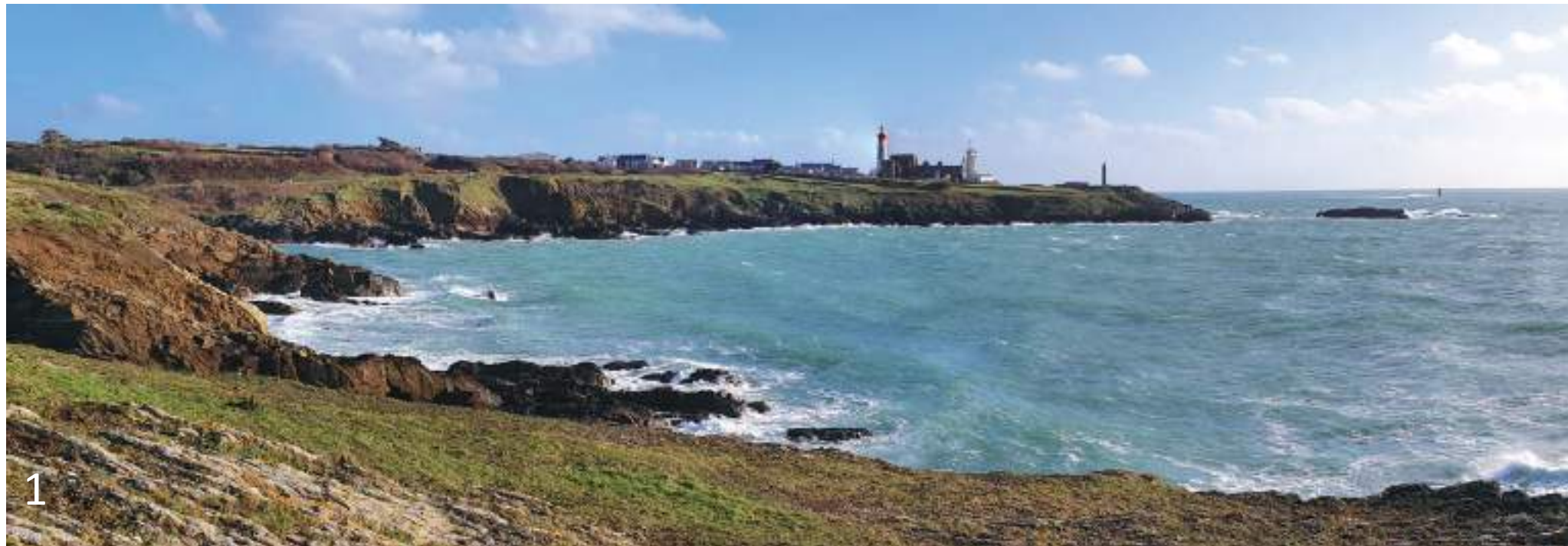
Vue de la pointe depuis le nord. La silhouette des bâtiments surmonte le socle de roche avancé en mer
