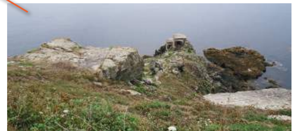
Pointe de Créac'h Meur : l'effet de seuil de l'unité paysagère est renforcé par la position des pas de tir, défendant l'entrée de la rade de Brest.
