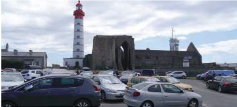
Le stationnement dévalorise le paysage des abords du phare et de l'abbaye. Une recomposition est nécessaire pour proposer une offre de places confortable mais moins impactante.
