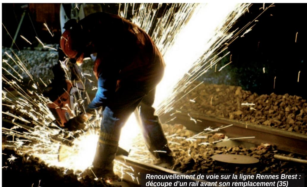
*Renouvellement de voie sur la ligne Rennes Brest : découpe d'un rail avant son remplacement (35)*
