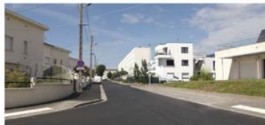
Lanester, rue Louis le Hon Illustration de la mixité urbaine et sociale résultant d'un complément de programme récent (petite unité d'habitation intermédiaire sur 3 niveaux) associée à deux programmes anciens de maisons jumelles à gauche et de collectifs au fond.
