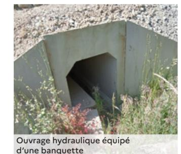
Ouvrage hydraulique équipé d'une banquette
