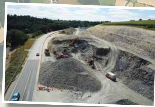
Terrassement dans le secteur du Cloître
