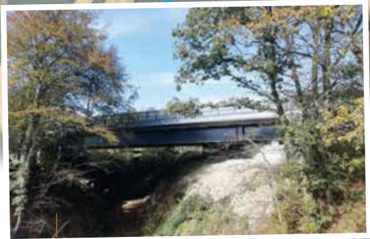
Ouvrage d'art n°3 : passage inférieur de la voie verte sous la RN164
