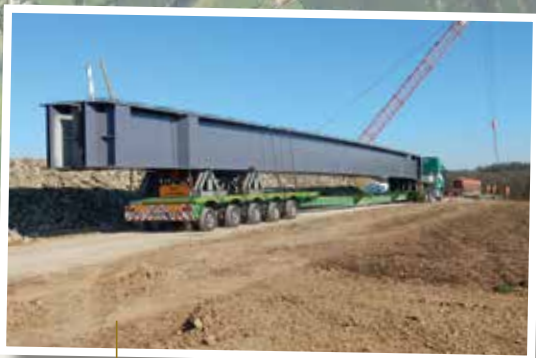
Transport en convoi exceptionnel de la poutrelle pour l'OA3
