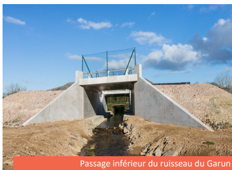
Passage inférieur du ruisseau du Garun
