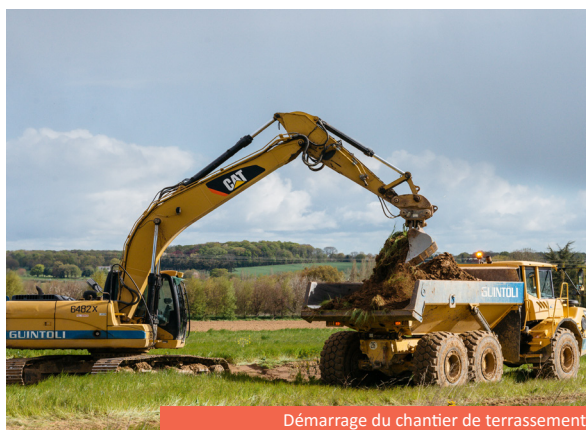
Démarrage du chantier de terrassement
