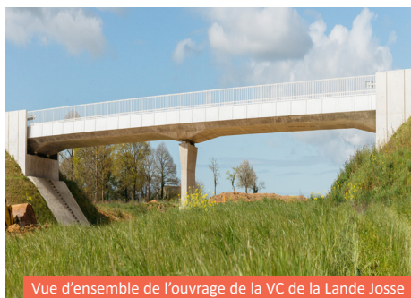
Vue d'ensemble de l'ouvrage de la VC de la Lande Josse
