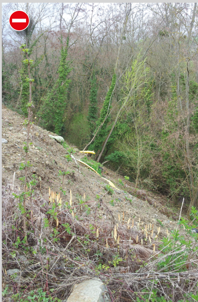
Défrichement non réalisé (© photo : DREAL).
