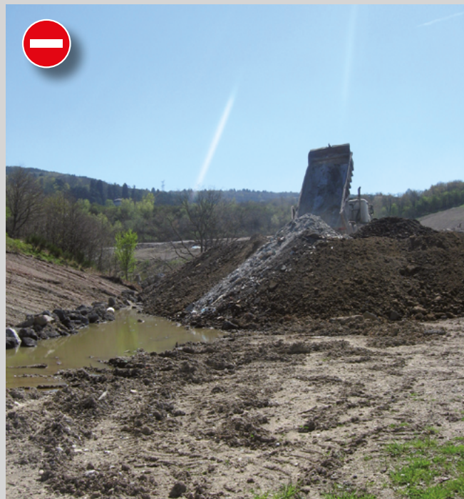
Mélange des bennes de déchets inertes sur la zone de contrôle (© photo : Cerema).
