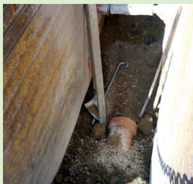
Tranchée d'une conduite d'eau potable
