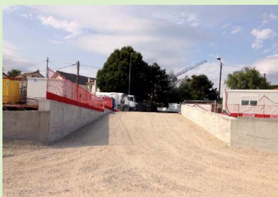
Rampe d'accès du chantier (pente de 10 %)
