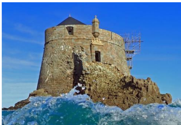
Figure 4 : Extrémité sud du fort concernée par les travaux de restauration (source : Arcadis)
