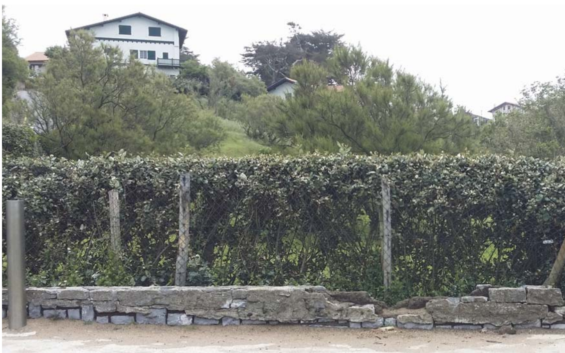
L'ancien mur et le grillage à la place desquels le nouveau mur devait être implanté.
