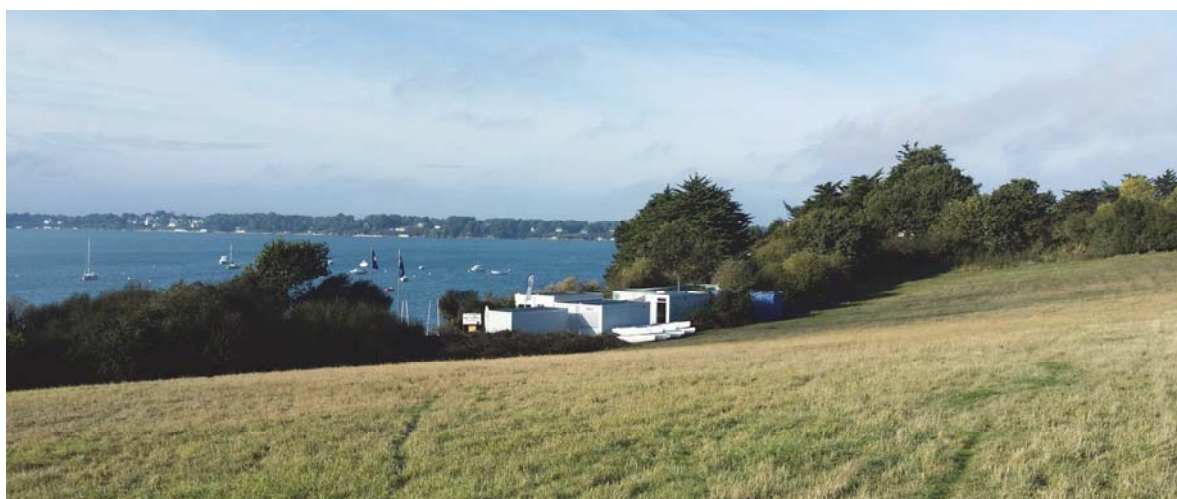
Les installations du centre nautique existant, en espace «remarquable».
