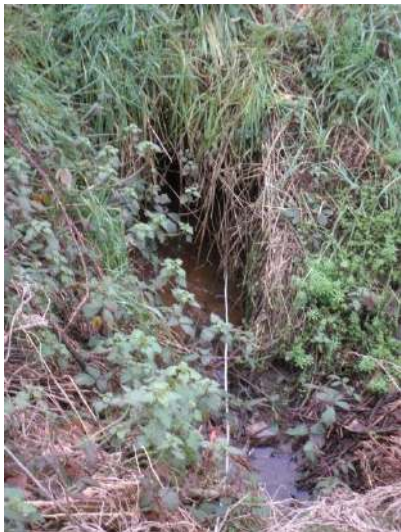
Photographie 5 : Tête amont de l'OH 2
