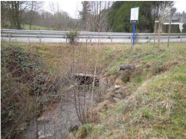
Photographie 43 : Tête amont de l'OHP-a
