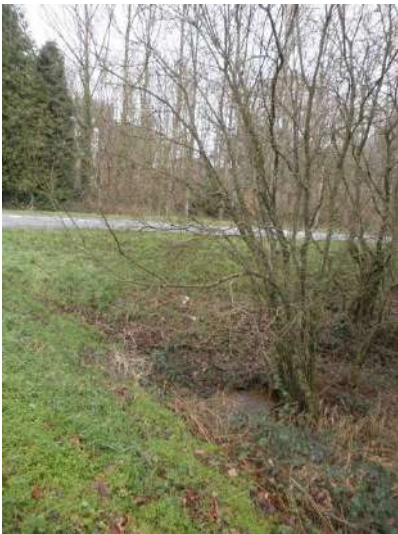
Photographie 13 : Thalweg 4 en aval de la RN164
