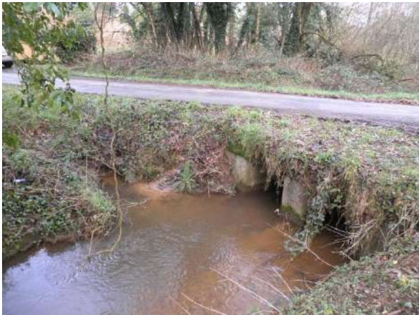
Photographie 35 : Tête aval OHP-e
