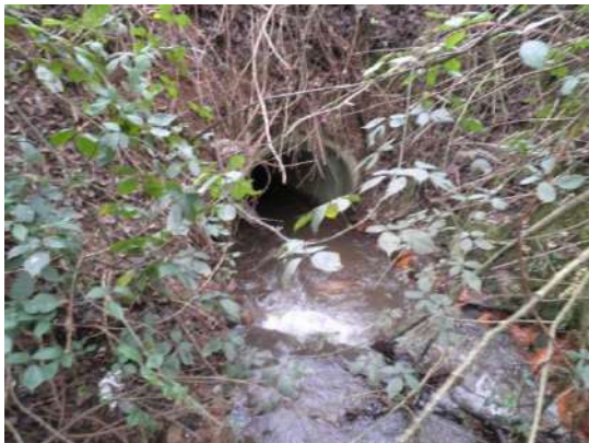
Photographie 18 : Tête amont de l'OH6
