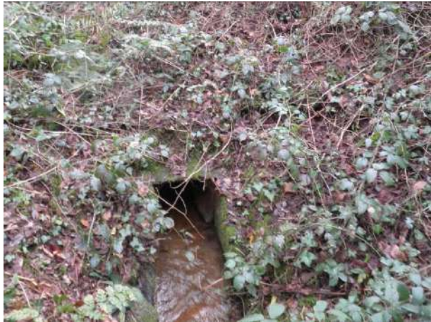
Photographie 2 : Tête amont de l'OH 1
