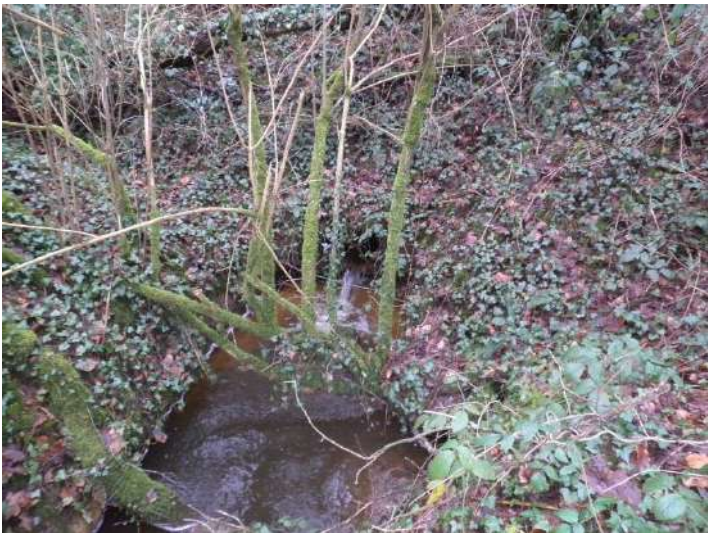
Photographie 23 : Tête aval de l'OH7
