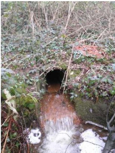
Photographie 6 : Tête aval de l'OH 2
