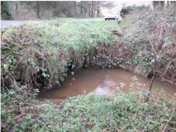
Photographie 34 : Tête amont OHP-e
