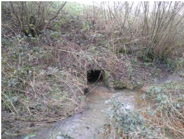
Photographie 15 : Tête amont de l'OH5
