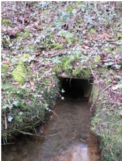
Photographie 22 : Tête amont de l'OH7
