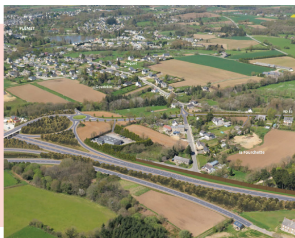
Carrefour de La Fourchette - Plémet Après travaux
