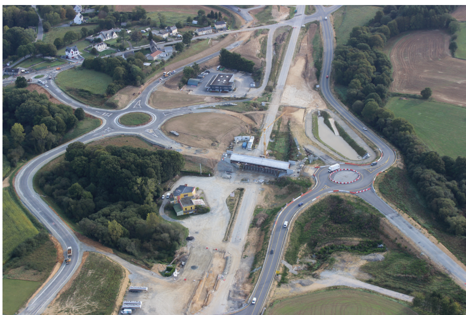
Echangeur Est Plémet - Travaux en cours - Octobre 2023
