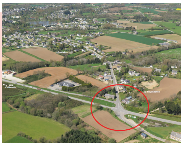
Carrefour de La Fourchette - Plémet Avant travaux
