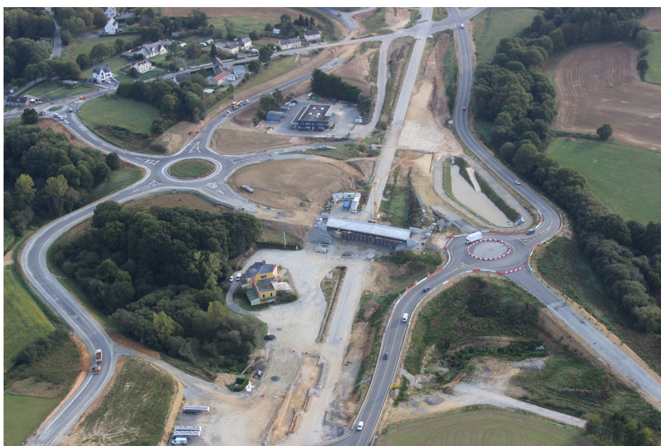
Echangeur Est Plémet - Travaux en cours - Octobre 2023
