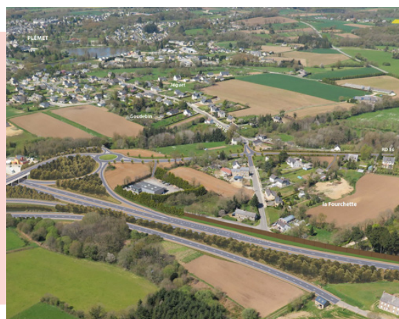
Carrefour de La Fourchette - Plémet Après travaux
