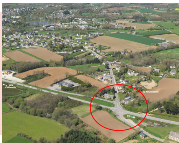
Carrefour de La Fourchette - Plémet Avant travaux
