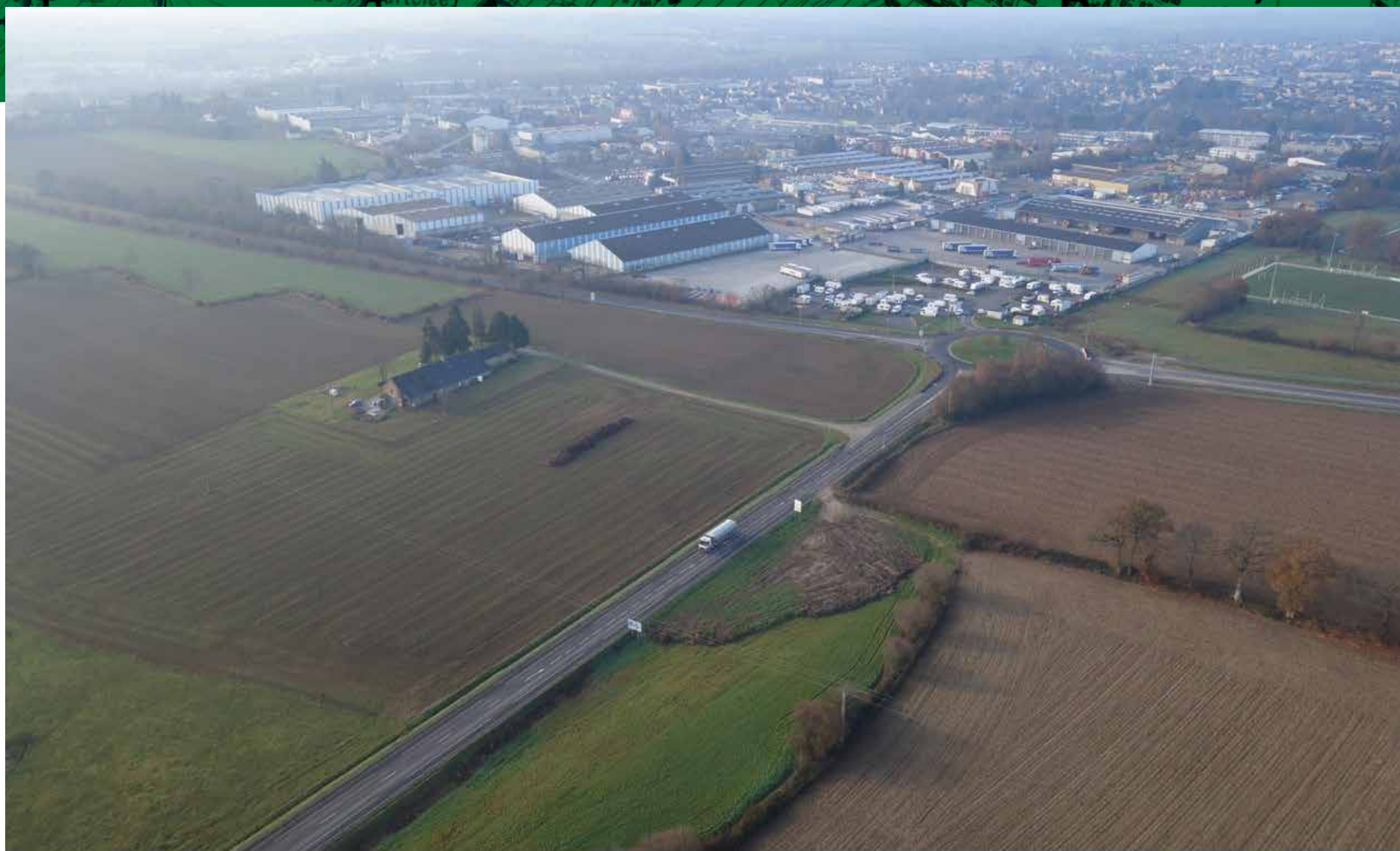
RN 12 Déviation de Beaucé Etat initial Secteur de Fougères Vue vers la zone industrielle de la Guénaudière
