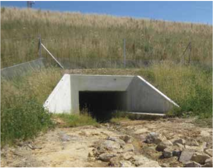
Figure 27 – Exemple de dalot
