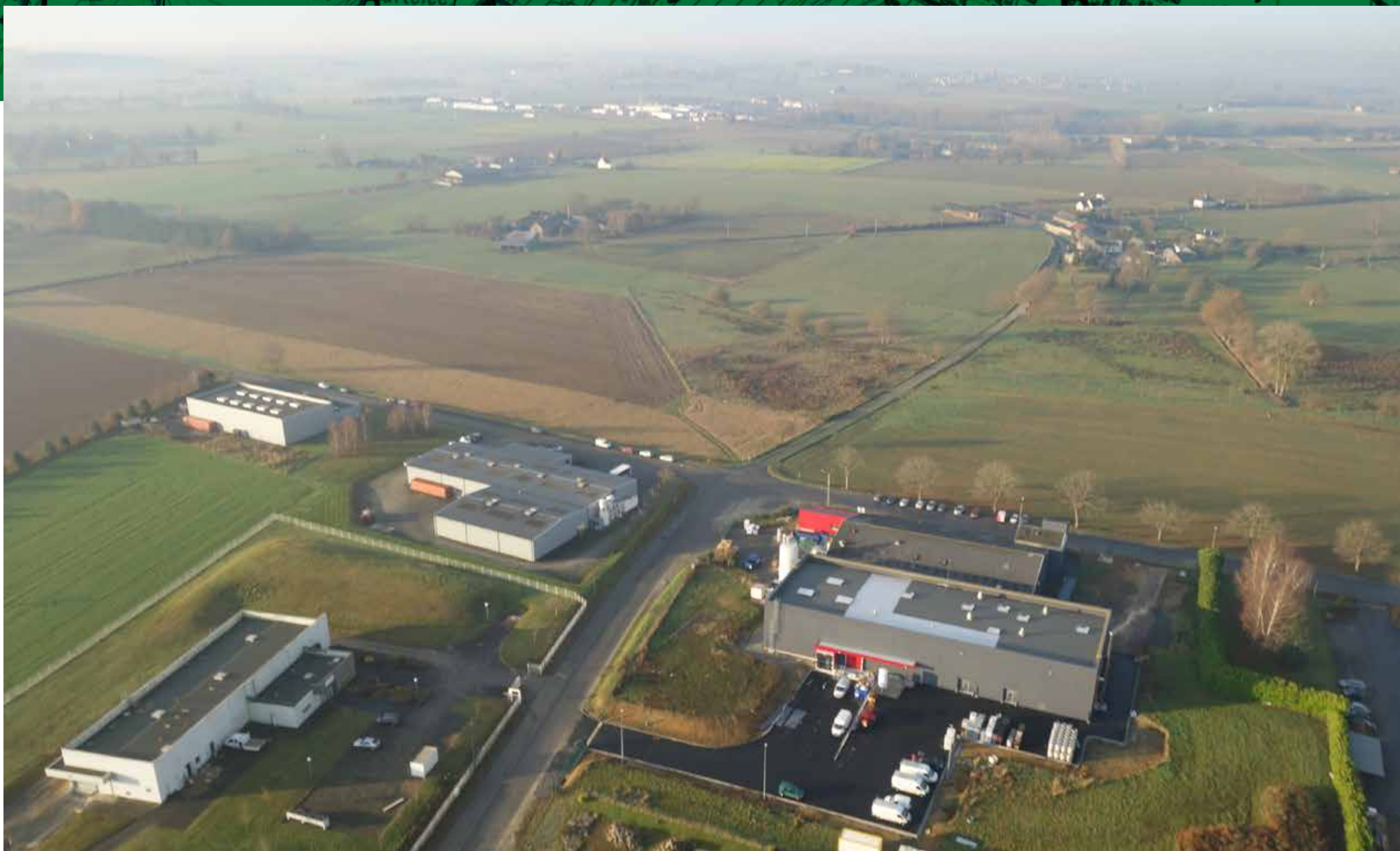
RN 12 Déviation de Beaucé
