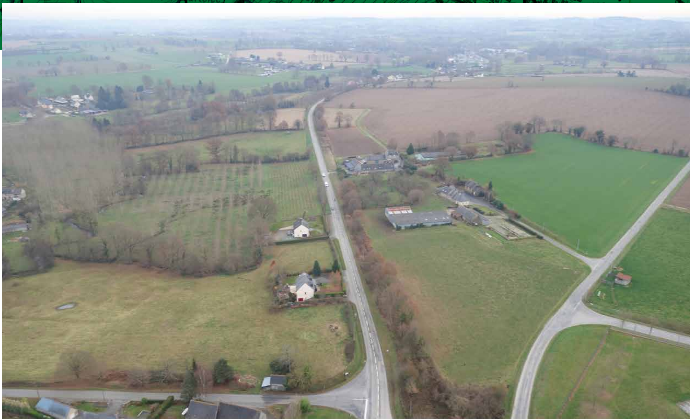
RN 12 Déviation de Beaucé
