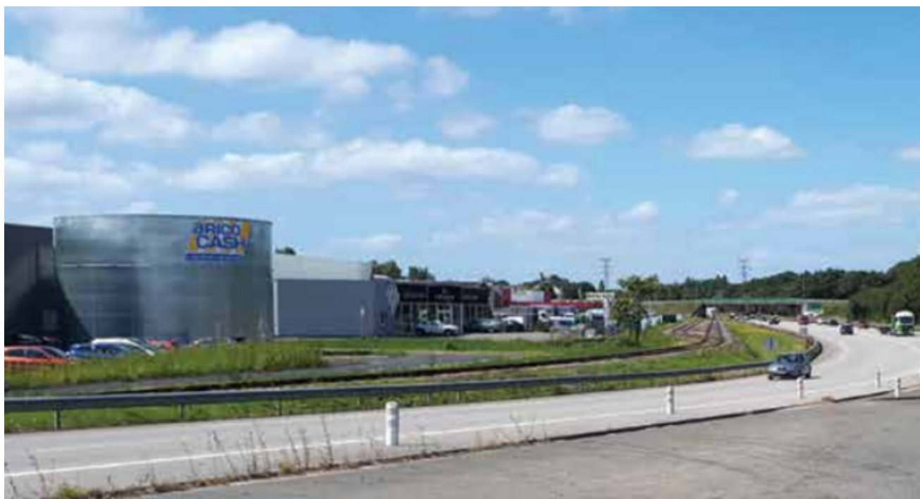
ILLUSTRATION 9 : BATIMENT BRICO CASH À PROXIMITÉ DE LA RN 165 AU NIVEAU DU GIRATOIRE DE TOULL DOUAR (SOURCE : DREAL BRETAGNE)
