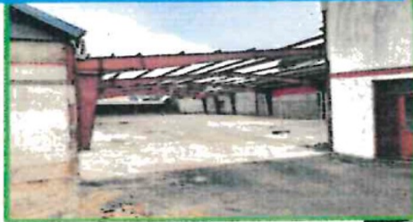
Vue sud des Bât. 2 et 3 découverts, et bât 1 à droite
