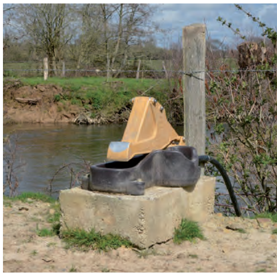
Suppression d'un abreuvement direct au cours d'eau par l'installation de pompe à museau et la pose de clôtures, sur l'Airou.
