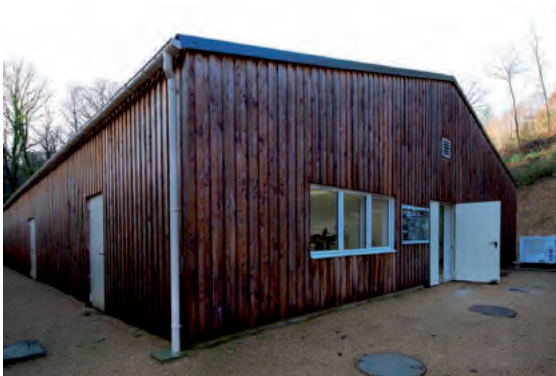
Bâtiment d'élevage des mulettes.
