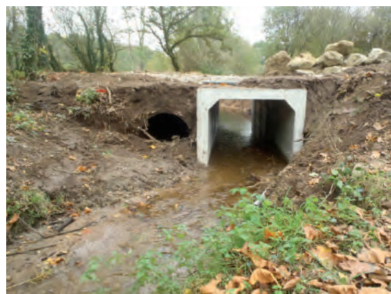
Remplacement d'une buse en métal, sous-dimensionnée, (à gauche) par un pont-cadre (à droite), sur le Bonne Chère.
