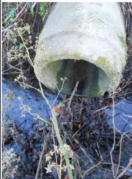
Exutoire de l'allée de Brocéliande
