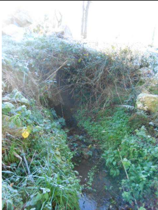
Pont cadre sous lequel passe le ruisseau en aval du lavoir
