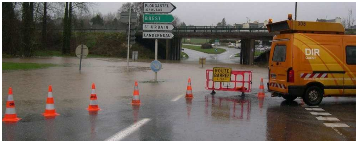
Figure 1 : Photo des inondations échangeur de Daoulas
