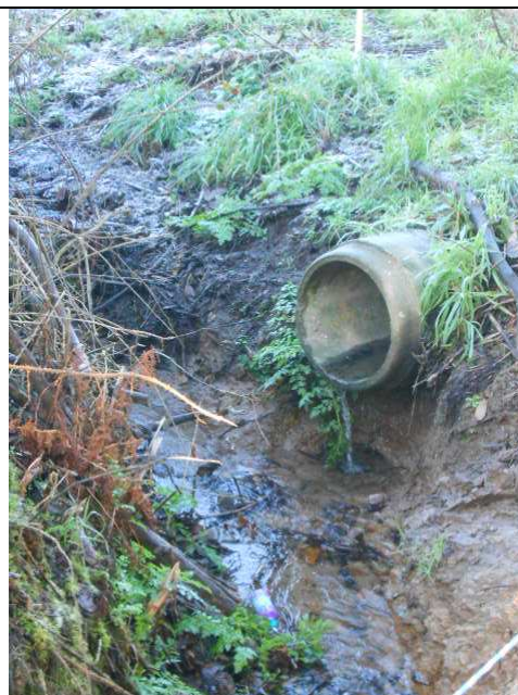
Exutoire de la résidence du Val
