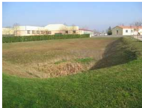
Figure 54 : bassin de rétention en forme de noue
