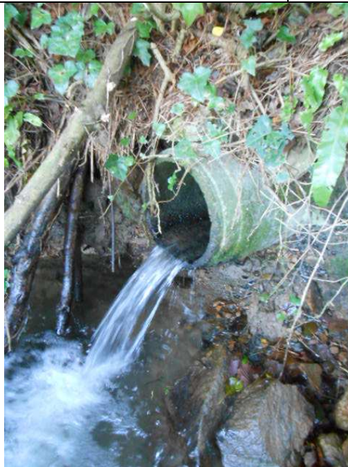
Busage du ruisseau sous le pont de Ménez Bargall à côté de l'exutoire
