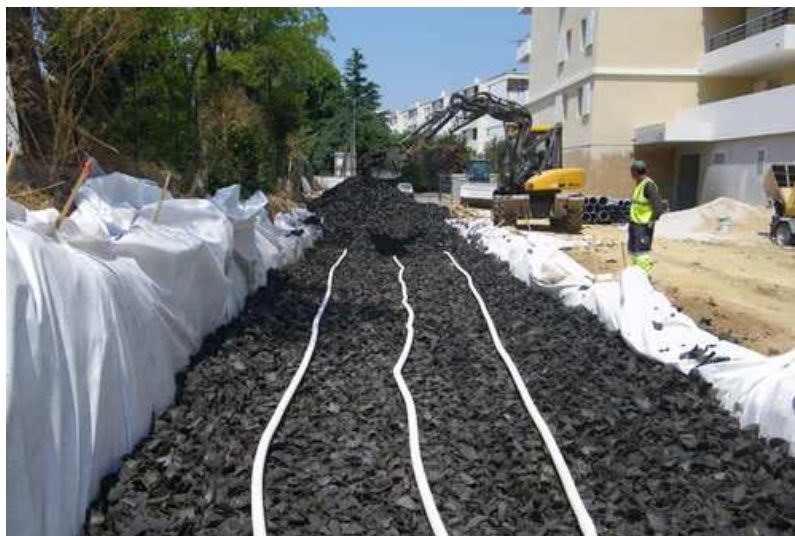
Figure 51 : exemple de dispositif d'infiltration des eaux pluviales
