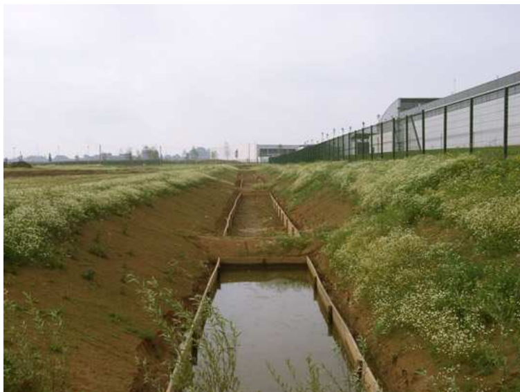
Figure 52 : exemple d'infiltration des eaux dans des noues et dans un puits d'infiltration
