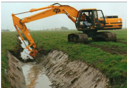
Figure 24 : Exemple de curage de fossé
