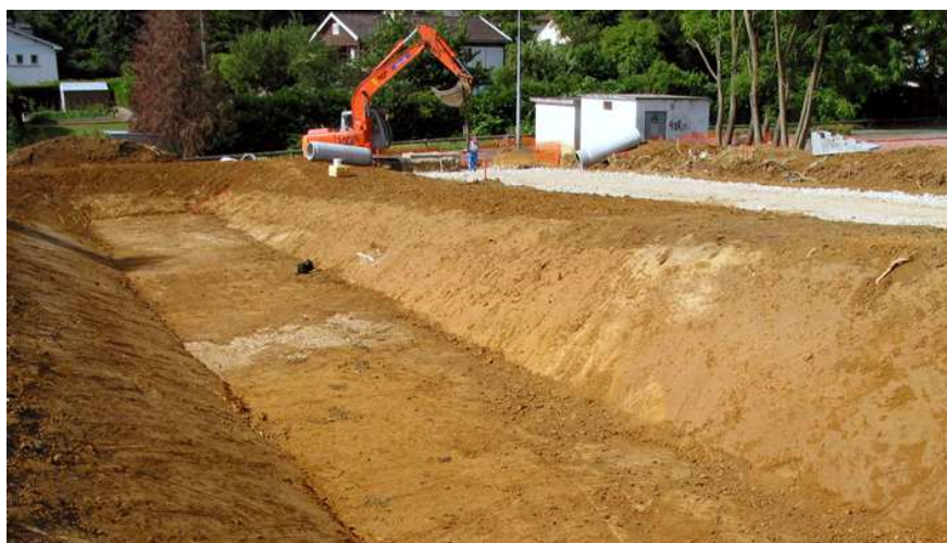
Figure 25 : Exemple de mise en place d'un bassin de rétention des EP
