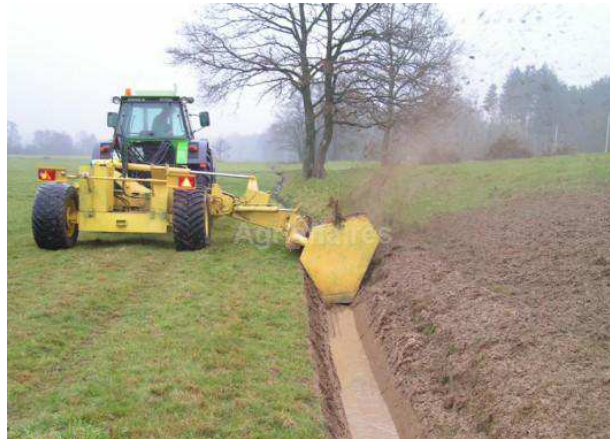
Figure 29 : Exemple de reprofilage et curage de fossé
