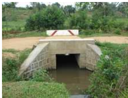
Figure 23 : Exemple de pose de dalot
