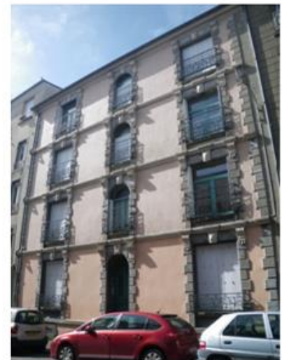
2657 – 34 rue de la République (immeuble urbain à forte ornementation)
