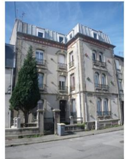
227 – 68 rue Massillon (immeuble empreint de modernité)
