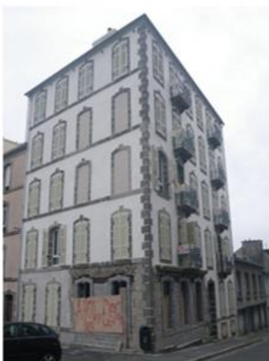
3693 – 23 rue Borda (immeuble urbain à forte ornementation)
