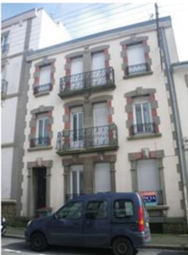
2051 – 57 rue de la République (immeuble urbain à forte ornementation)
