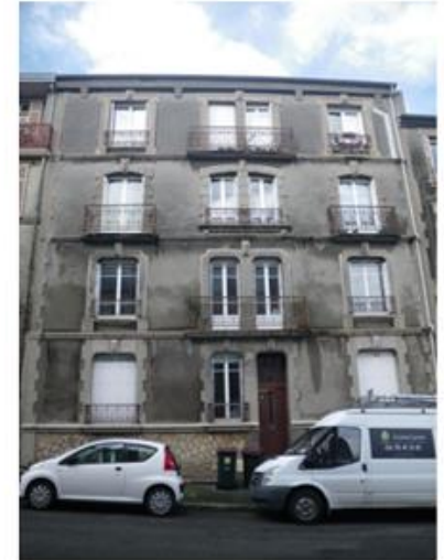
2643 – 8 rue Choquet du Lindu (immeuble urbain à forte ornementation)
