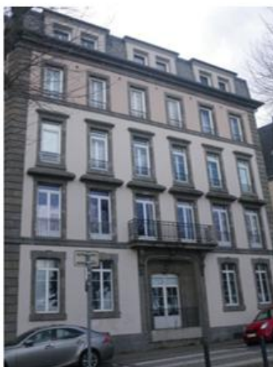
4498 – 1 rue Neptune (immeuble urbain à forte ornementation)
