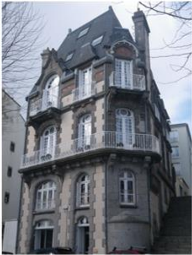
4470 – 20 rue de Denver (immeuble empreint de modernité)
