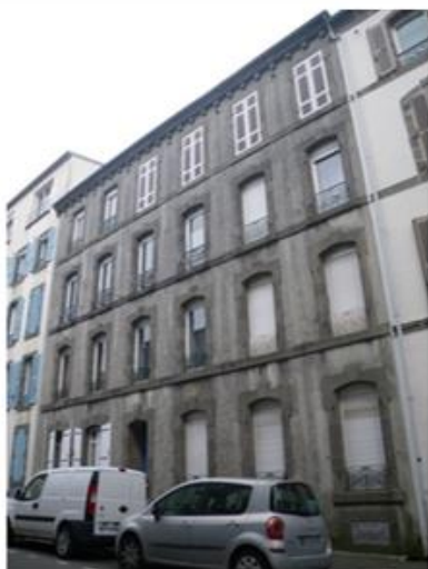
945 – 1 rue Turenne (immeuble urbain à faible ornementation)
