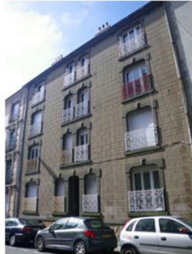
2621 – 36 rue de la République (immeuble urbain à forte ornementation)
