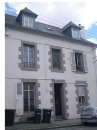
2833 – 9 rue Jules Guesde (immeuble de marque néoclassique)
