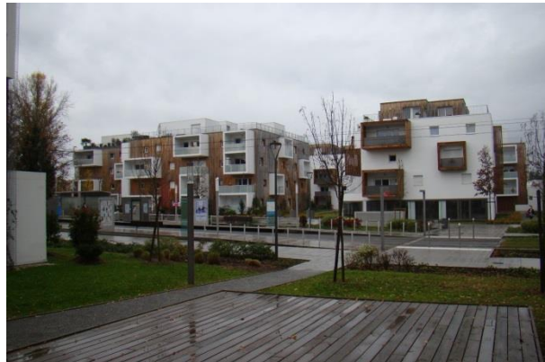
Chemineements doux amenant à un arrêt de transport en commun, PAE du Pontet, Ville de Pessac
