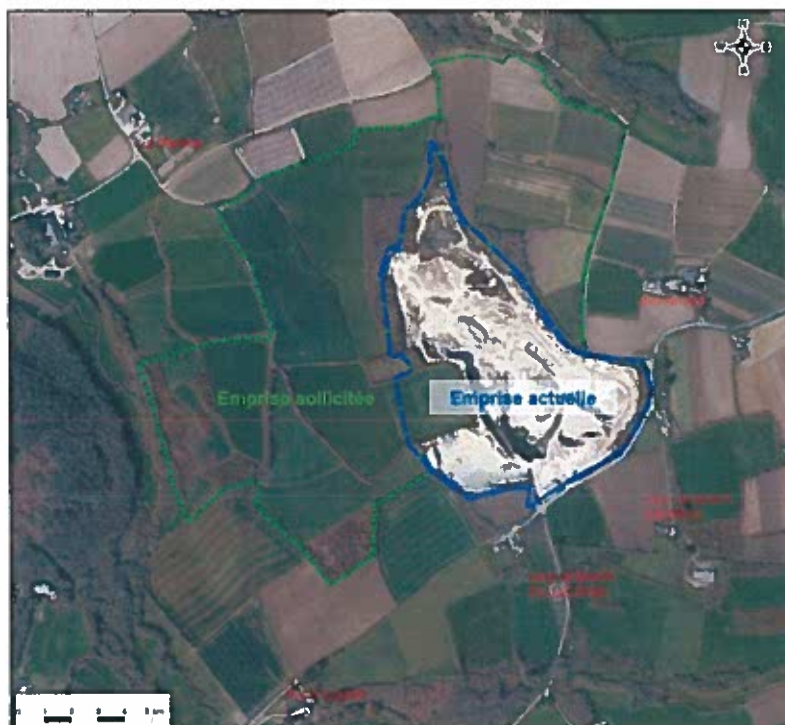
Vue aérienne de la carrière (source : étude d'impact)
