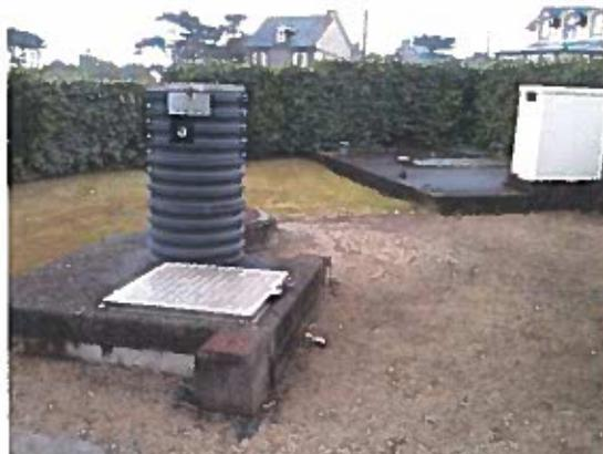
Photo 3 : Poste de relevage (vue de l'extérieur)
