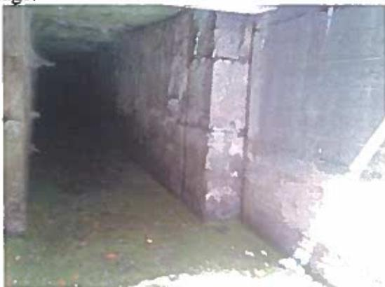
Photo 2 : Arrivée du canal d'évacuation des eaux pluviales vers le poste de relevage
