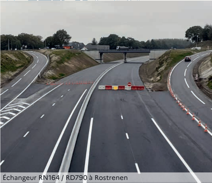
Échangeur RN164 / RD790 à Rostrenen
