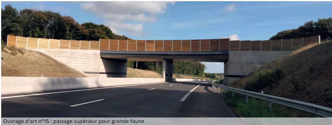
Ouvrage d'art n°15 : passage supérieur pour grande faune
