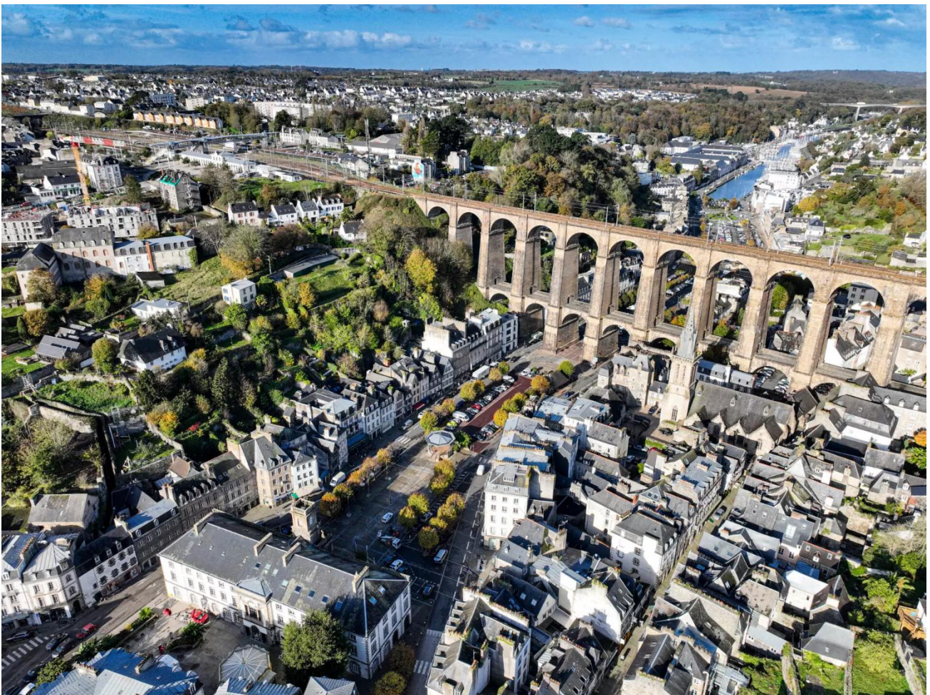
Vue aérienne de Morlaix - crédit photo : BMa-Dronistair
