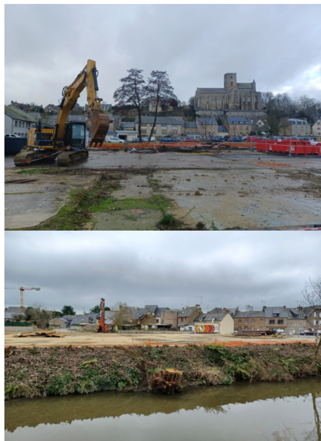
Figure 6 : chantier en cours (@Lamballe-Armor)
