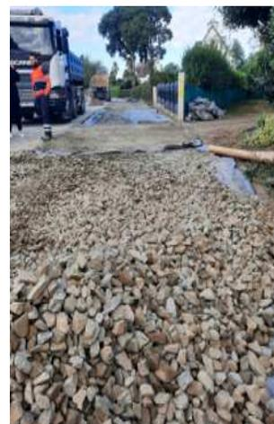
Travaux de mise en place des structures drainantes
