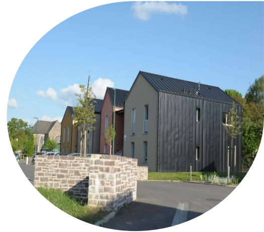
L'îlot des Lavandières, Boisgervilly (35)
