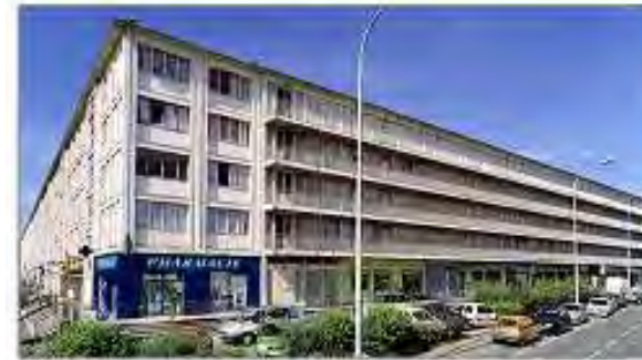
Drancy - Cité de la Muette Avenue J. Jaurès, rue Fontaine et Blanqui Vue de la façade arrière à long de l'avenue Auguste Blanqui © inventaire général / Département de la Seine-Saint-Denis / cl. S. Asseline ADAGP 2003 0291N082
