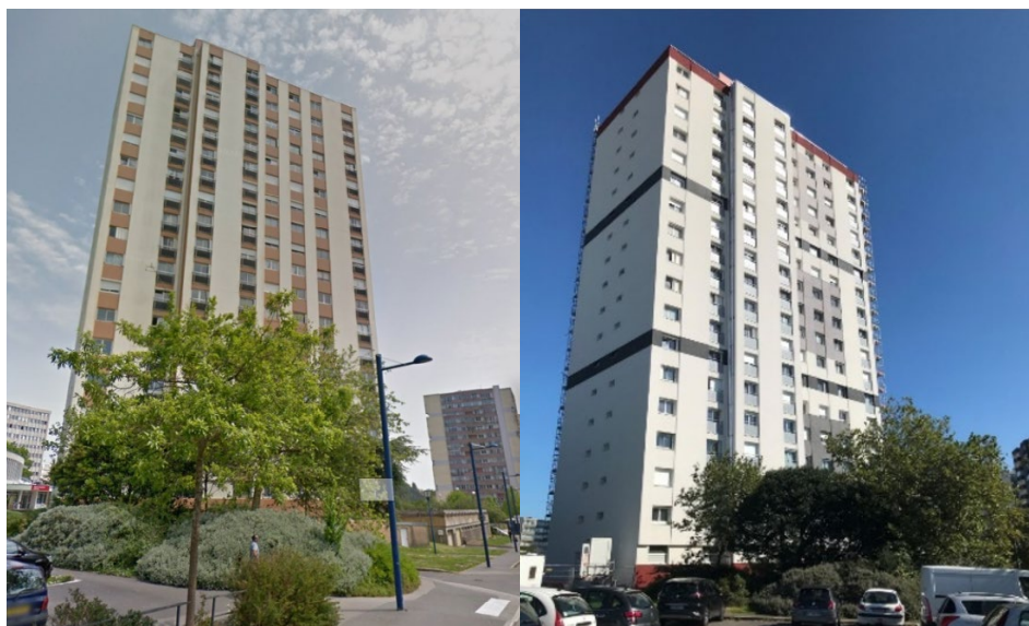
Copropriété fragile à Brest, avant et après travaux.
