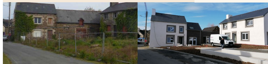
Réhabilitation à Tressignaux, avant et après
