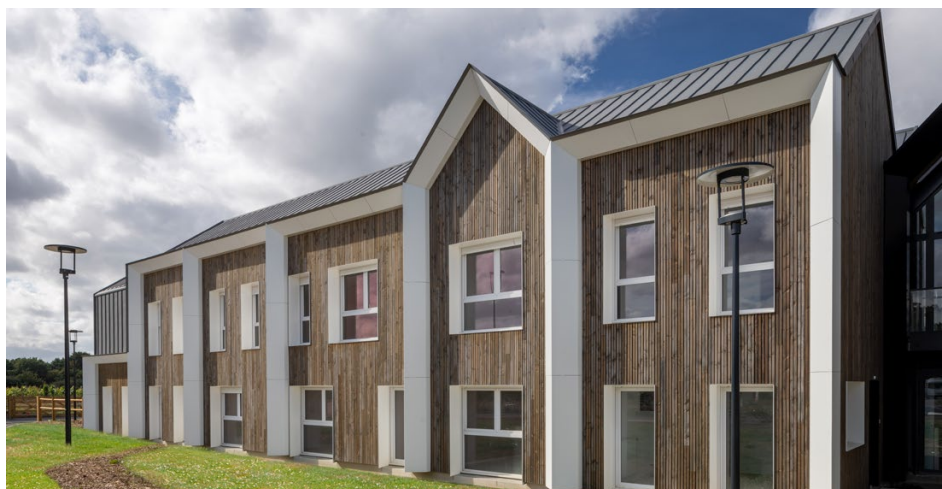
Résidence d'accueil et foyer de vie à Noyal-Châtillon-sur-Seiche
