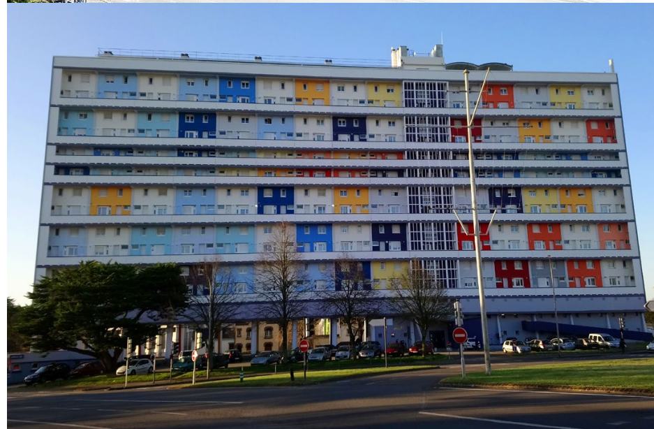
Exemple de réhabilitation à Moustoir, avant et après
