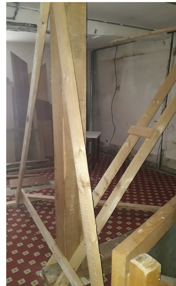
Copropriété rue St-Melaine à Rennes, avant travaux
