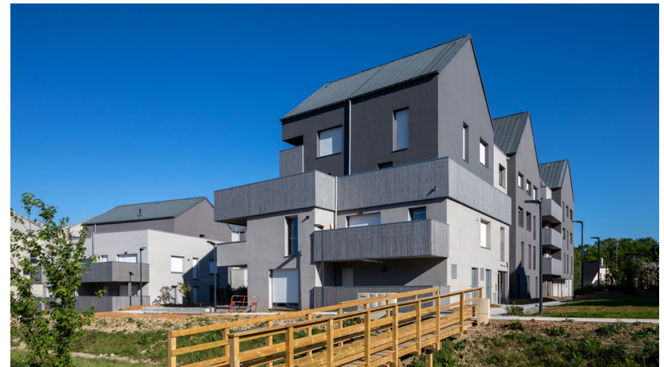
Exemple de logement collectif à Bruz
