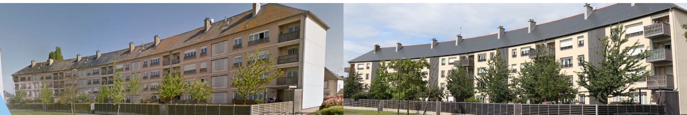
Exemple de réhabilitation à Saint-Malo, avant et après
