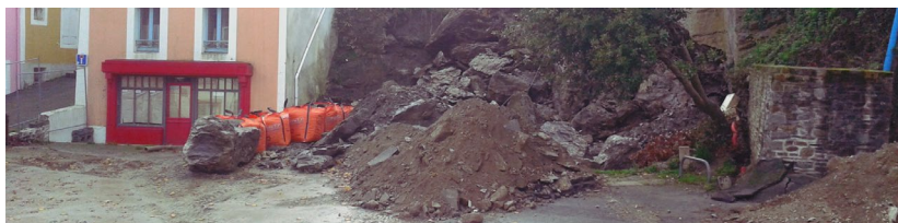
Éboulement à Sauzon (source : DDTM56)
