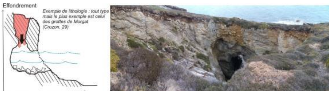
Illustration 58 : Effondrement sur la bordure nord de l'anse de Dinan (Camaret, 29).
