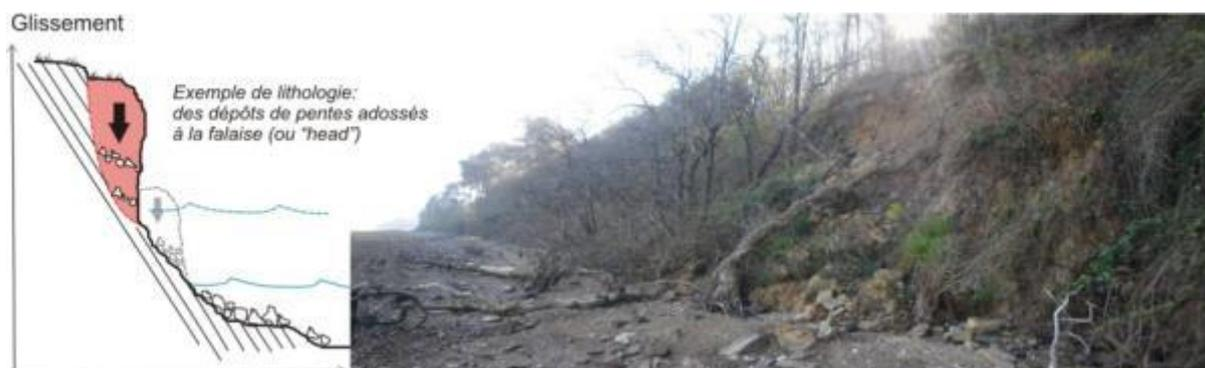
Illustration 62 : Schéma de principe d'un glissement de terrain (Landevennec, 29).
