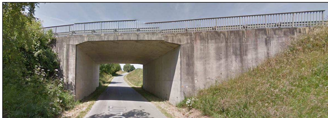
Figure 31 : Vue du PI de la RD407 côté élargissement au Sud (source Google street view)
