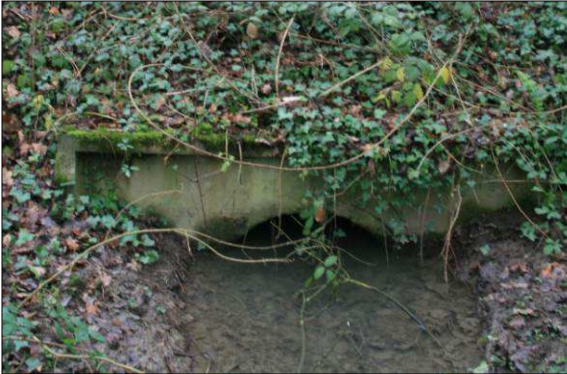
Figure 41 : Vue de la buse existante (source ARCADIS)
