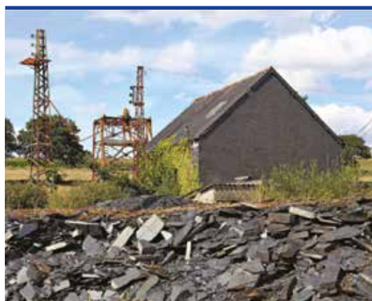
Chevalement et bâtiment abritant le treuil d'extraction - Ardoisières de Maël-Carhaix
