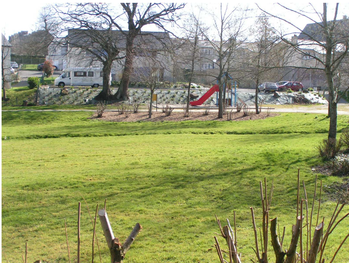
Photo 5 : Ouvrage double fonction : aire de jeux / bassin à sec – Bassin de Ste Anne (Dinan)
