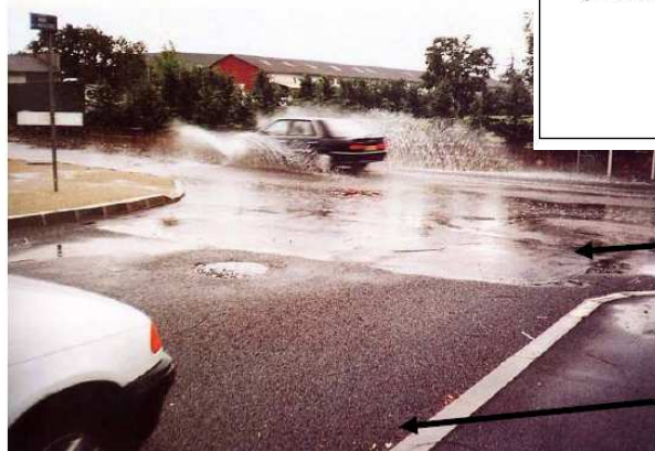
Chaussée à structure réservoir, Craponne (CERTU - 1994)
