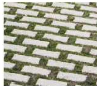
Pavage en béton avec ouvertures de drainage
