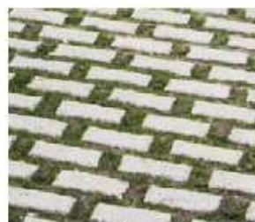
Pavage en béton avec ouvertures de drainage
