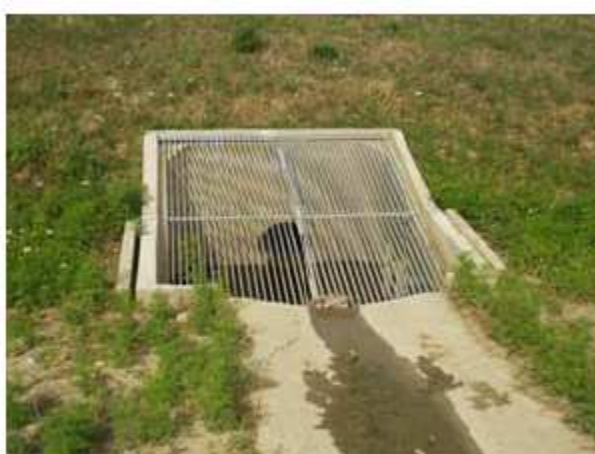
Grille de protection sur ouvrage de sortie
