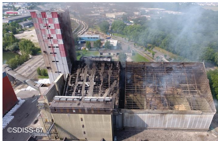
Vue du silo après l'explosion
