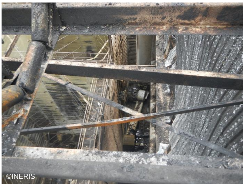
Vue de l'espace inter-silo depuis le convoyeur au niveau de la galerie sur-silo
