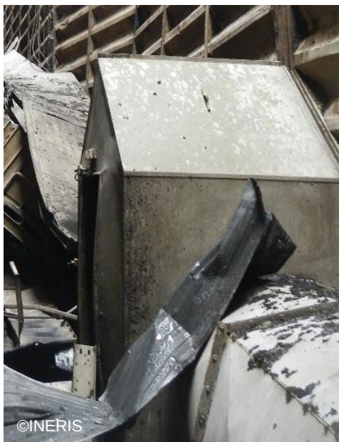
Déformation du châssis support de la porte
