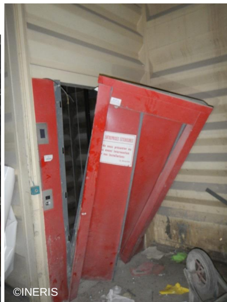
Porte ascenseur au niveau 1
