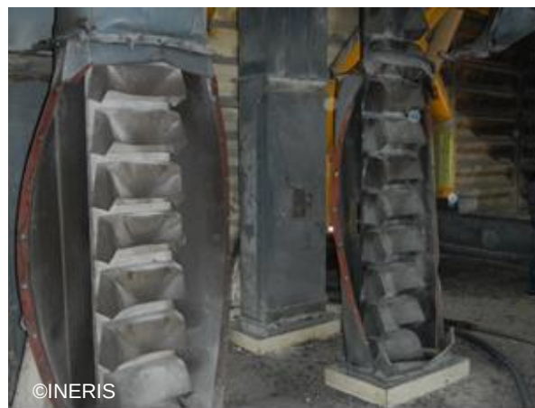
Elévateur au niveau 4
