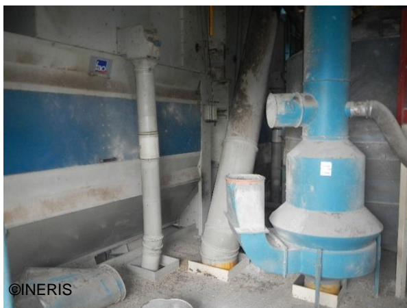
©INERIS Empoussièremment, niveau 6 de la tour de manutention
