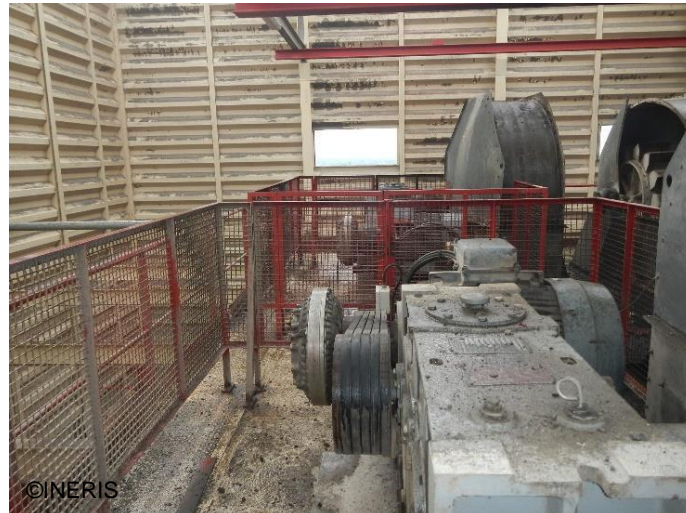
Empoussièrément, niveau 9 de la tour de manutention
