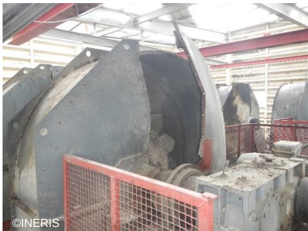
Plaques de la tête de l'élévateur déformées et en partie arrachées
