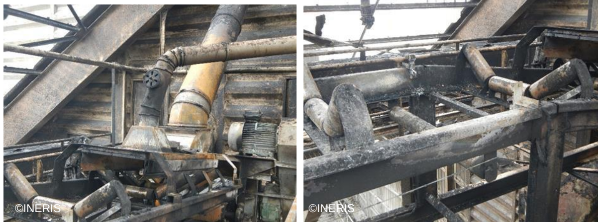
Bandes transporteuses dans le silo béton
