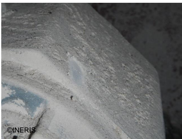
©INERIS Empoussièremment, niveau 3 de la tour de manutention
