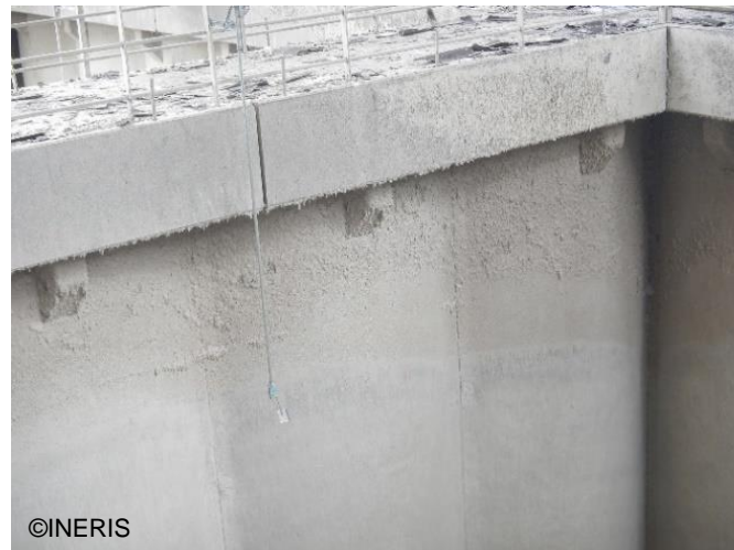
Empoussièrément, cellule béton
