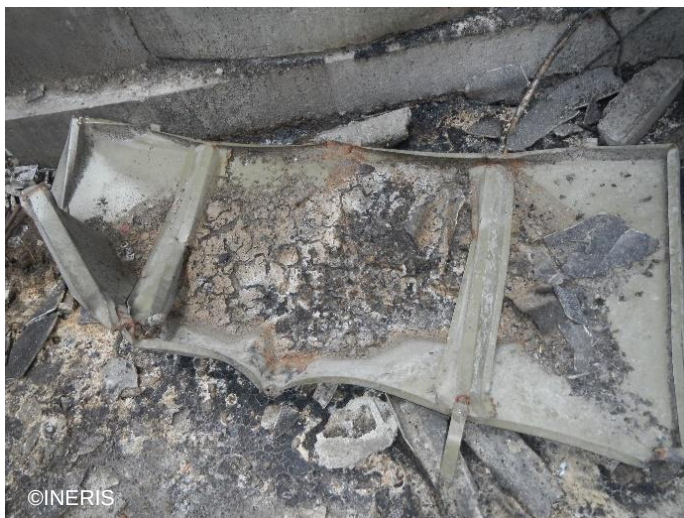
Projection et déformation de la porte
