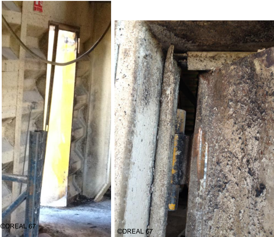
Chambranle déformé
