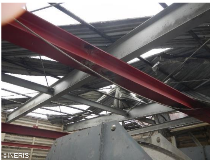
Toiture de la tour de manutention
