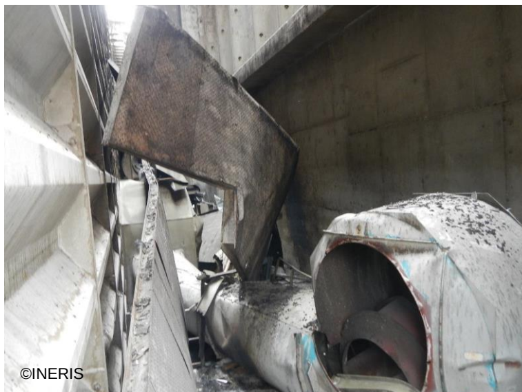
Vue de l'espace inter-silo depuis le bas avec traces de combustion en face de l'accès à la galerie sous-cellules métalliques
