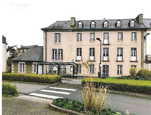
Vue de la friche (ancienne trésorerie), quai de Viarmes, Lannion
