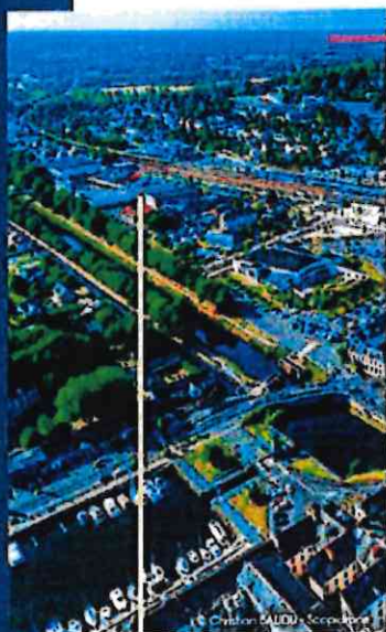
Site avant déconstruction 2020
