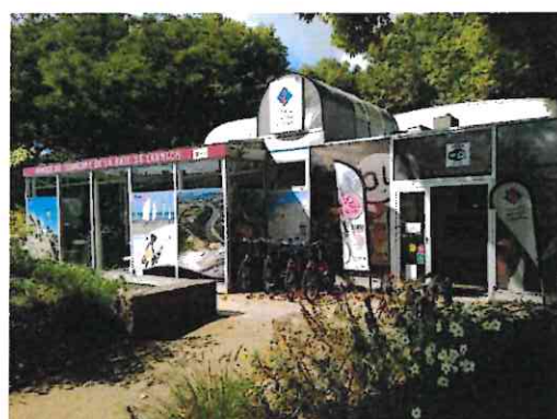
Vue du Bureau d'information touristique actuel de Lannion (à démolir)
