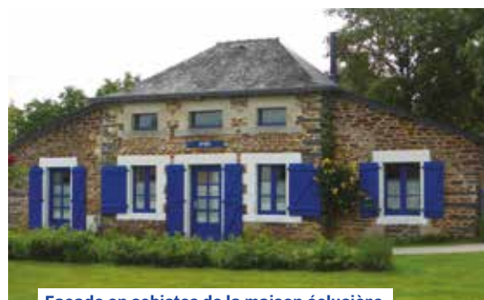
Façade en schistes de la maison éclusière (Apigné (35))
