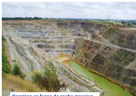
Carrière en fosse de roche massive (PIGEON - Louvigné-de-Bais (35))
