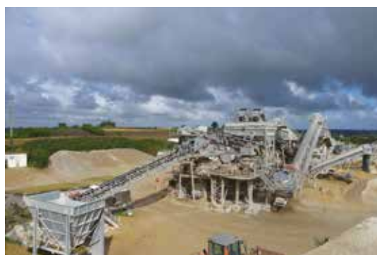
Installation de traitement des matériaux en carrière (BODERIOU - Plouvorn-Mespaul (29))
