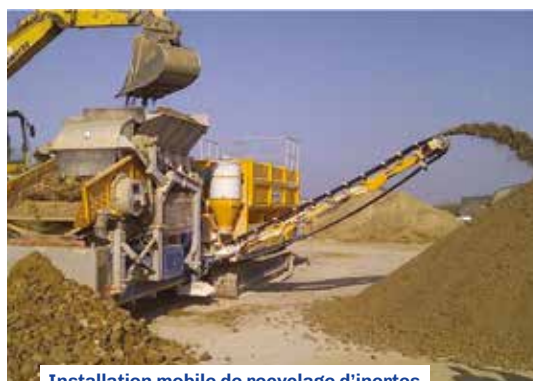
Installation mobile de recyclage d'inertes (MARC - Chantepie (35))
