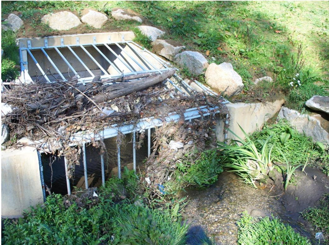
Ouvrage de fuite coté amont du barrage
