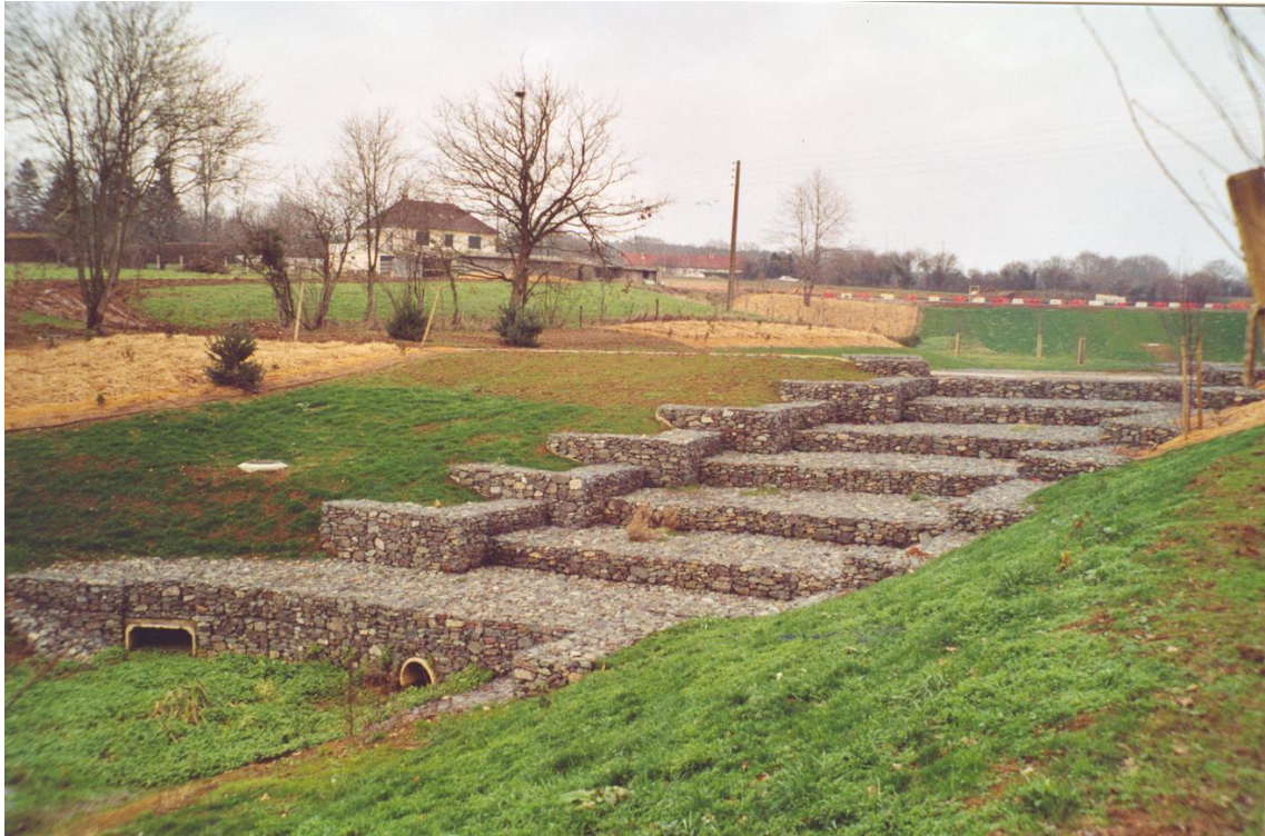
Déversoir en Gabions de forme escalier
