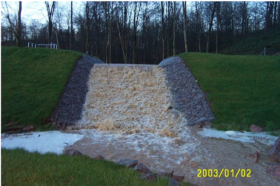
Déversoir rectangulaire en gabion
