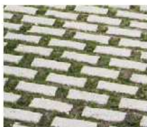
Pavage en béton avec ouvertures de drainage
