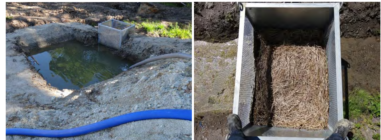
Photographie 26 : Exemples de dispositifs d'assainissement provisoire mis en place en phase travaux (© Egis / D. Ferreira)
