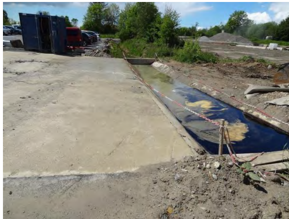
Photographie 27 : Exemple de bassin de stockage de produits polluants, d'aire de lavage de goulotte de toupies et d'aire de lavage d'engins équipée en sortie d'un débourbeur-déshuileur (© Egis / D. Ferreira)
