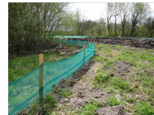
Photographie 20 : Exemple de fixation de bavolet et barrières anti-intrusion posées (© Egis)
