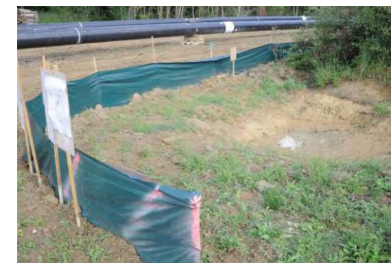
Photographie 21 : Coude de retournement en limite d'emprises du chantier (© Egis)
