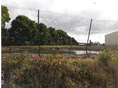
Photographie 1 : Bassin de rétention (Source : Egis)
