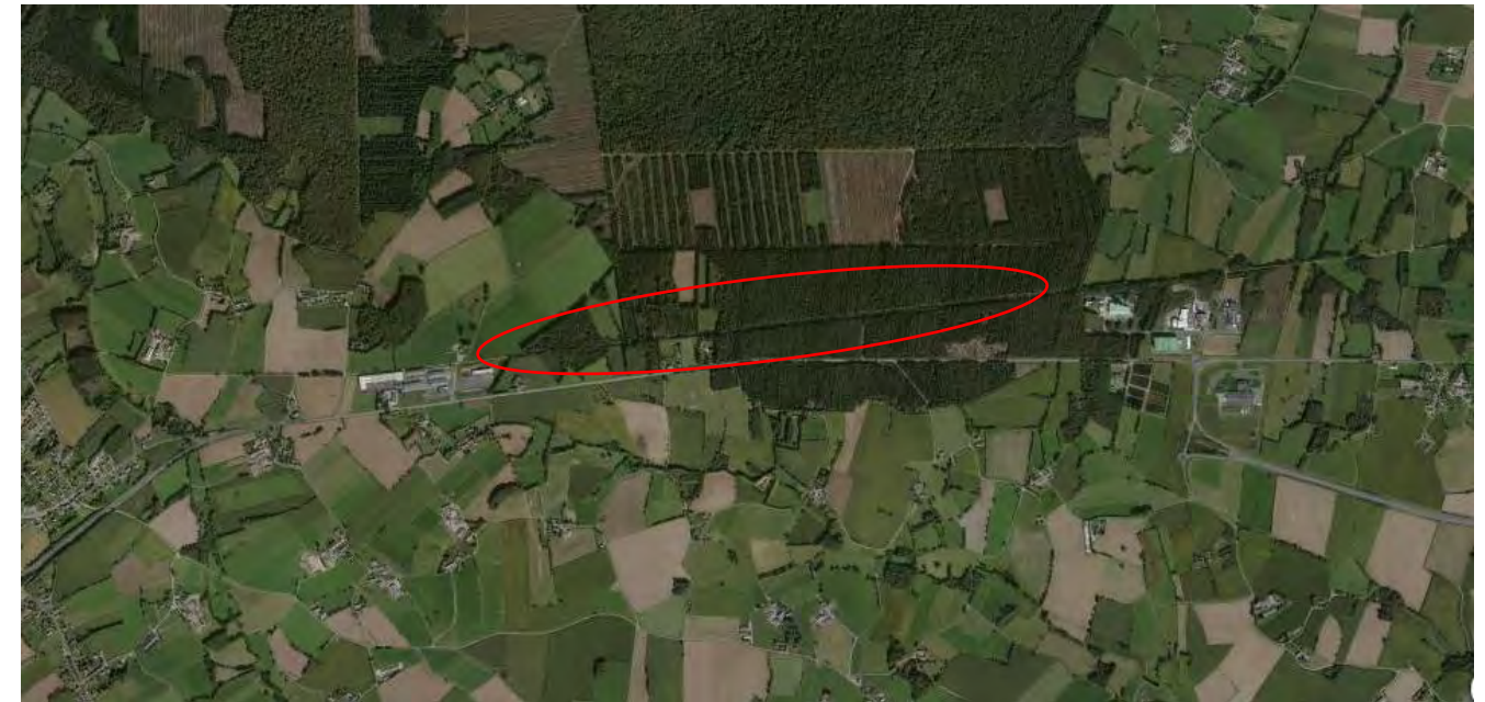
Figure 65 : Image aérienne actuelle (Source : géoportail)
