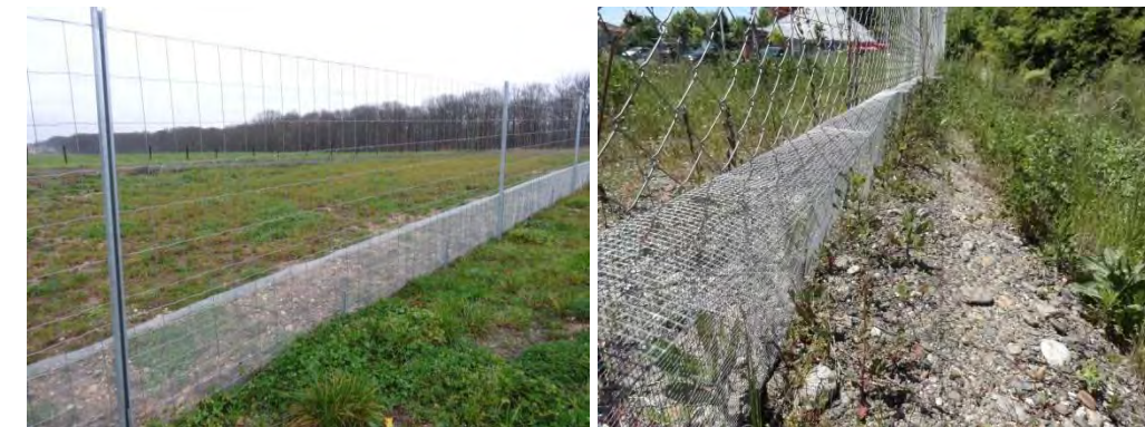
Photographie 29 : Exemple de clôtures à mailles fines 5 mm x 5 mm
