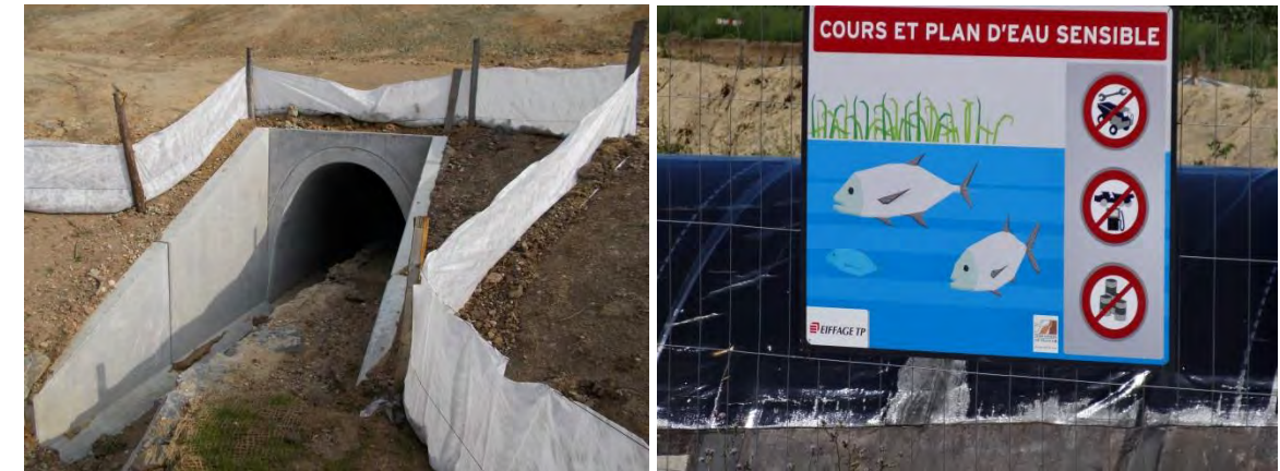
Photographie 28 : Principe d'implantation de clôtures géotextile pour protéger le cours d'eau du Pont Herva et les milieux avoisinants et panneau de sensibilisation (© Egis / D. Ferreira)
