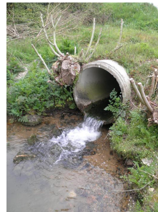
Photographie 15 : Le Lotavy - vue aval de l'ouvrage de la RN 164
