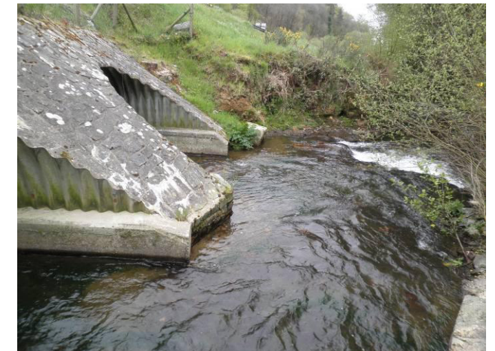
Photographie 8 : Le Poulancre - vue aval de l'actuel ouvrage de la RN 164
