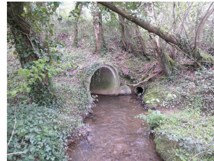
Photographie 9 : Le Saint-Guen - vue amont de l'ouvrage de la RN164
