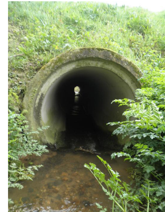
Photographie 14 : Le Lotavy - vue amont de l'ouvrage de la RN 164
