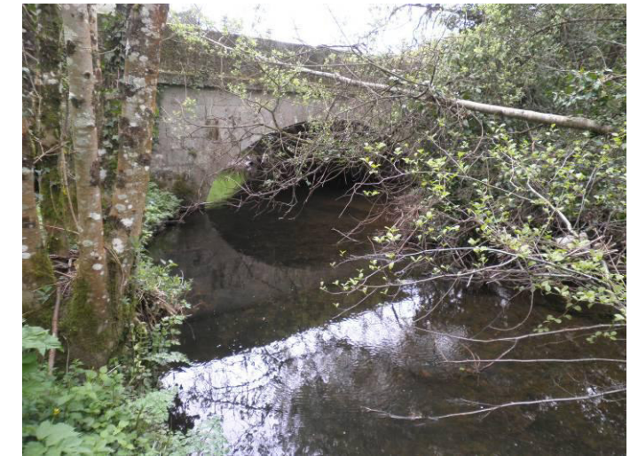
Photographie 6 : Le Poulancre - vue amont de l'ancien ouvrage de la RN 164
