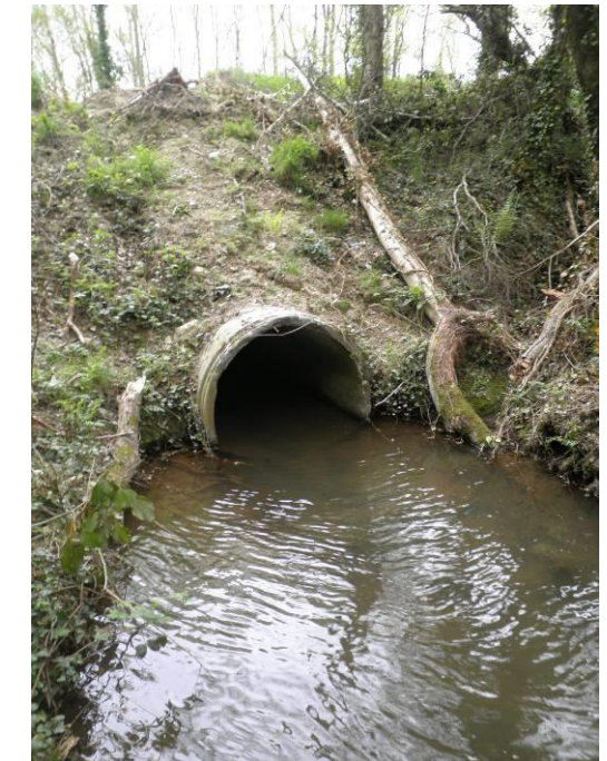
Photographie 10 : Le Saint-Guen - vue aval de l'ouvrage de la RN 164
