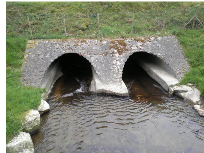
Photographie 7 : Le Poulancre - vue amont de l'actuel ouvrage de la RN 164
