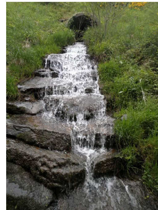
Photographie 3 : Le Guer- vue aval de l'ouvrage de la RN 164
