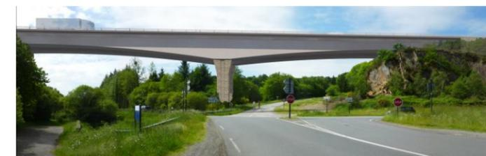
*Variante Nord (et Mixte) : Solution béton précontraint*
