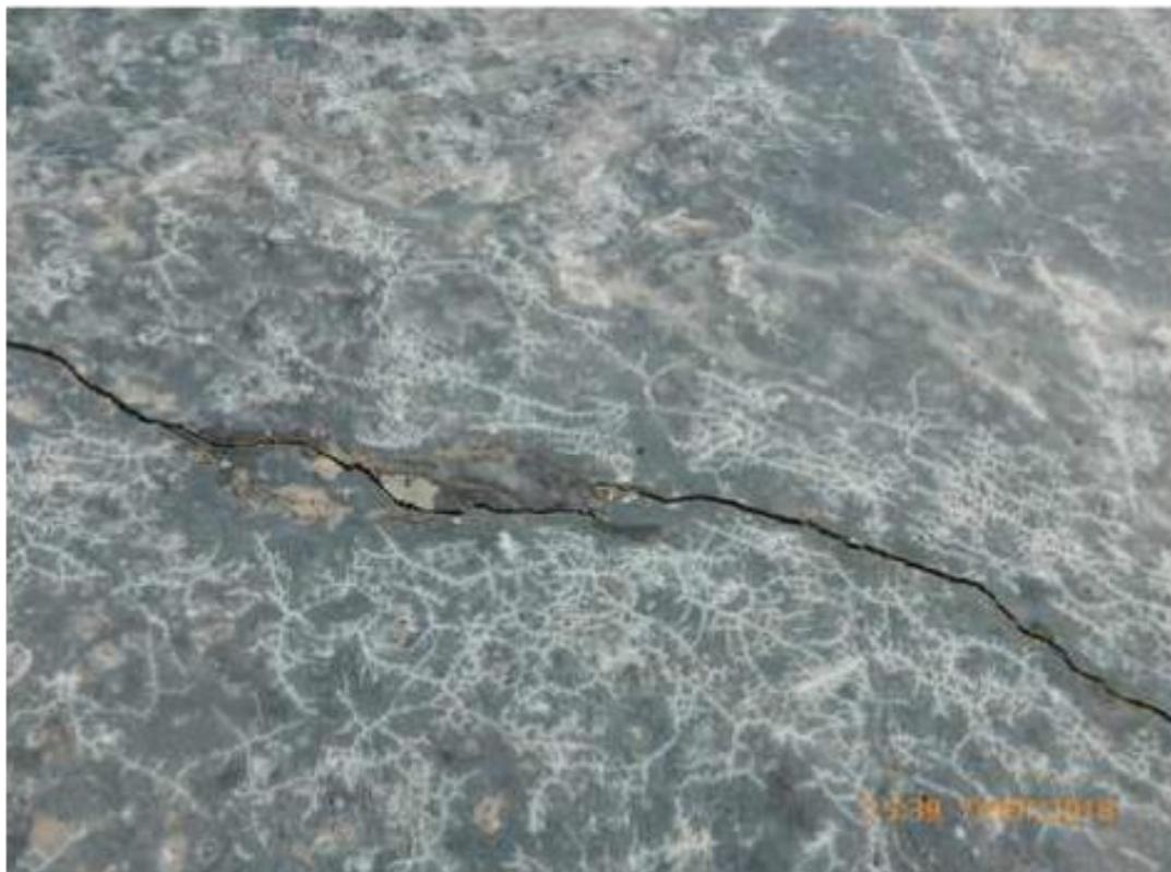
**Fissure sur un fond de fosse, résultant d'un colmatage du système de drains sous la fosse**
